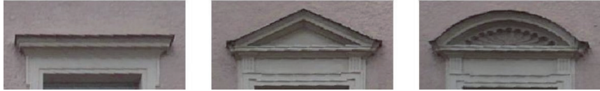
Abb. 2: Verdachungsformen: Fenstergesims (links), Dreiecksgiebel (Mitte) und Bogensegment (rechts).
