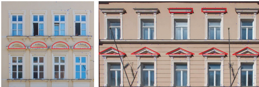
Abb. 6: Ergebnisse der Detektion von Verdachungen bei zwei Bildern von Fassaden aus Freising. Beide Bildausschnitte wurden entsprechend entzerrt und ausgeschnitten. Neben den Verdachungsformen für Bogensegmente, Dreiecksgiebel und Gesims werden auch die vor der Fassadenwand liegenden Punkte angezeigt. Diese liegen vor allem im Bereich der Verdachungen.
