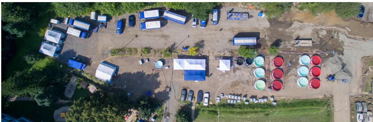
Abbildung 10: Luftbild der Trinkwasseraufbereitungsanlage, Quelle: THW/Lukas Hannig
