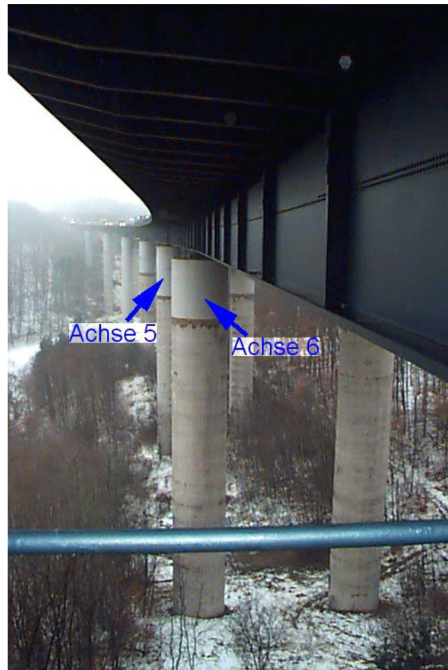
Bild 9.6: Achsen 5 und 6 der Haseltalbrücke (vom Würzburger Widerlager in Richtung Frankfurt blickend)
