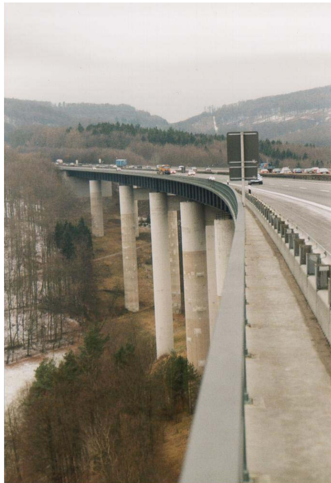
Bild 9.4: Haseltalbrücke (von Würzburg in Richtung Frankfurt blickend)
