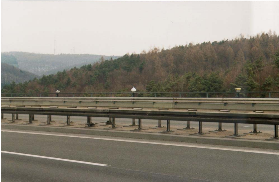
Bild 9.17: GPS-Antennen auf der Nordseite zwischen den Achsen 5 und 6
