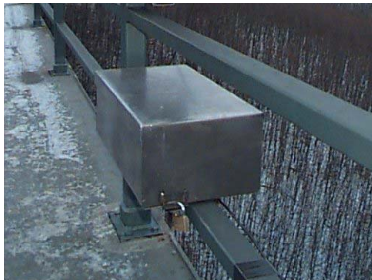
Bild 9.9: Abschließbare Gerätebox zur sicheren Unterbringung und zum Schutz der GPS-Empfänger
