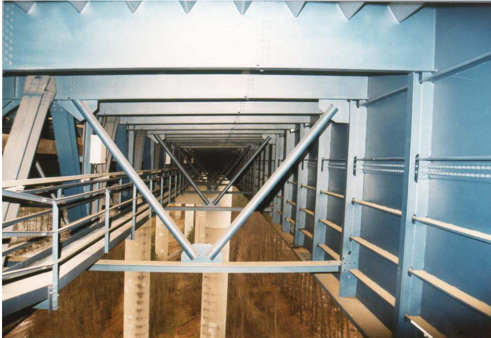
Bild 9.5: Unterseite der Brücke mit Stahlträgerkonstruktion und Wartungsweg (links)
