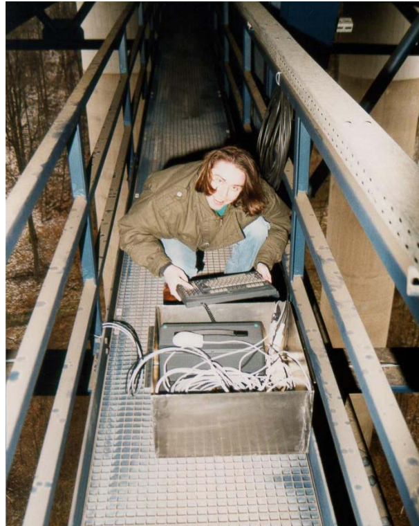
Bild 9.14: Zentralrechner für alle Monitorstationen
