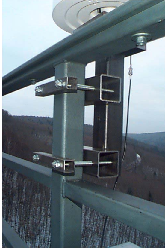
Bild 9.7: Spezialhalterung für die Montage der GPS-Antennen am Brückengeländer
