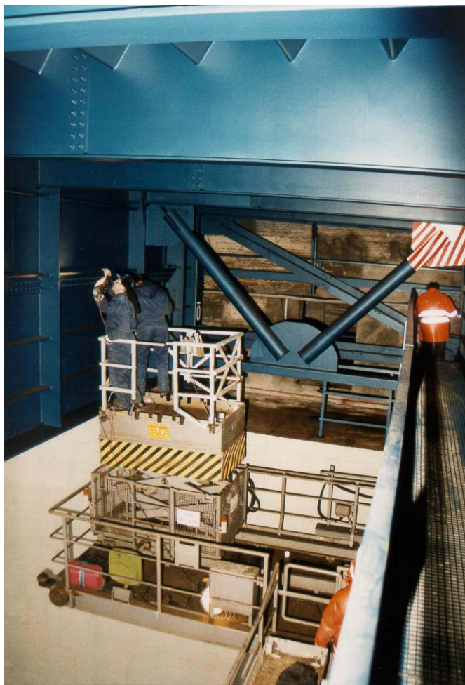
Bild 9.11: Blick auf den Inspektionswagen, der für die Verkabelungsarbeiten genutzt wurde
