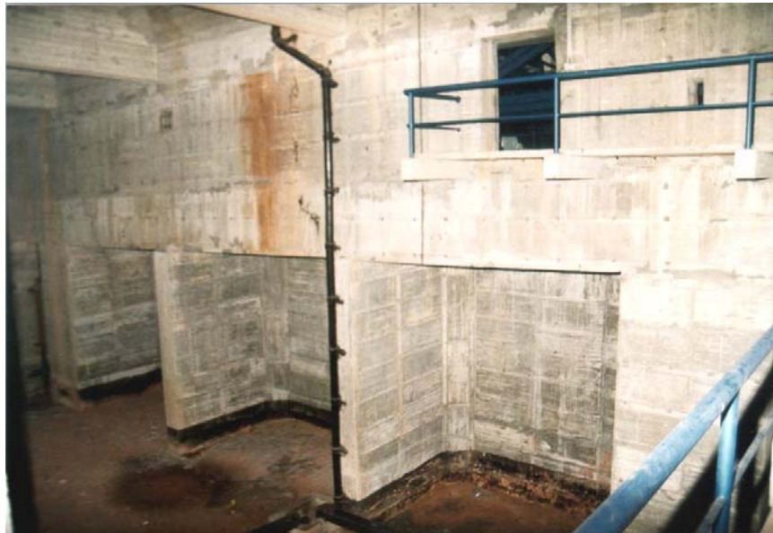
Bild 9.16: Widerlager auf der Würzburger Seite (im oberen Bildausschnitt ist der Zugang zur Brücke zu erkennen)
