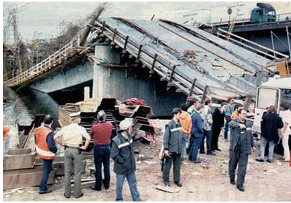
Figure 5-1: Highwaybridge Aschaffenburg http://www.arminwitt.de/schreck.htm
