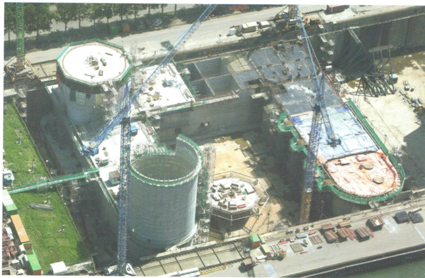
Рис. 11. Вид на строительство спуско-подъемного комплекса компании MPU (MPU Heavy Lifter)
