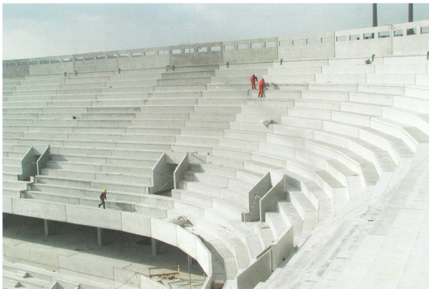
Рис. 7. Элементы из самоуплотняющегося бетона (LC25/28 D1,6) с высококачественными поверхностями для верхнего и нижнего ограждений верхней трибуны стадиона Фольксваген-Арена в Вольфсбурге (Фото: Liapor)
