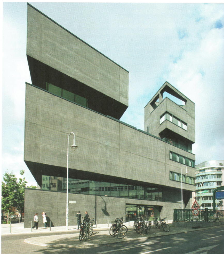
Рис. 10. Берлин, Линиенштрассе, 40, архитектура: Bundschuh Architekten/Cosima von Bonin, LC16/18 D1,4 (Фото: Liapor)
