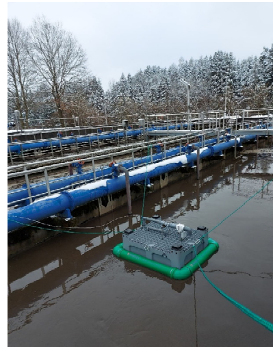
#2 Denitrifikation (Einbau Messhauben)
