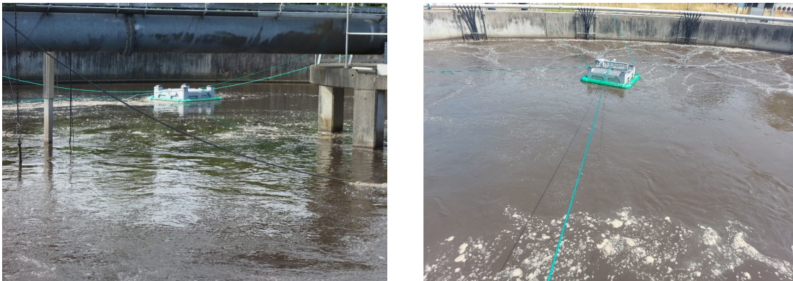
Abbildung 32: Messstelle #1 unbelüftete Zone (links) und #2 belüftete Zone (rechts) des Belebungsbeckens der Kläranlage #B
