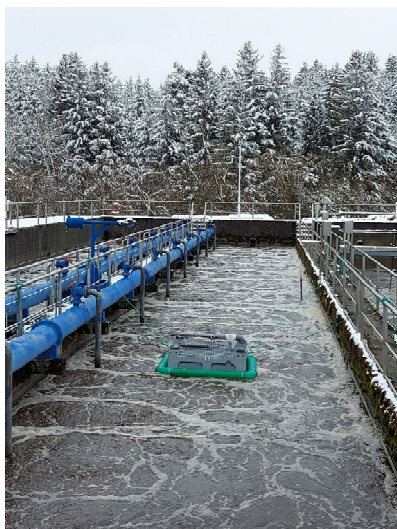
#3 Nitrifikation (Einbau Messhauben)
