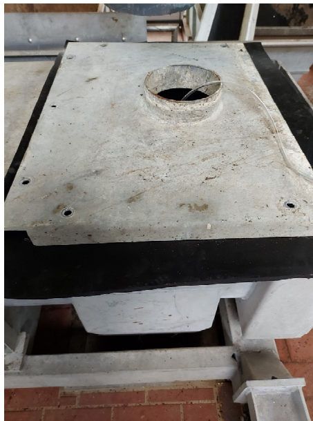
Abbildung 28: Messstelle #4 Förderband mit entwässertem Klärschlamm
