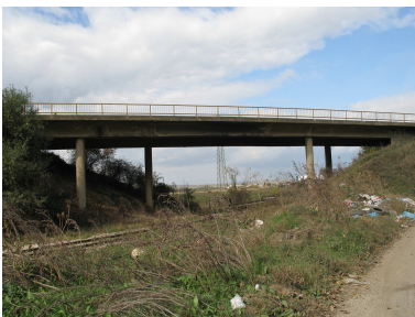
Bild 1.5: Ansicht einer Brücke zur Dokumentation der filigranen Bauweise der Pfeiler
