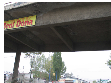
Bild 1.6: Detailaufnahme zur Dokumentation der filigranen Konstruktionsweise im Feld- und Stützbereich des Brückenüberbaus
