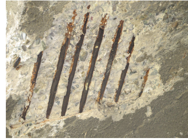
Bild 1.4: Detailaufnahme eines Brückenüberbaus zur Dokumentation des Zustands der Bewehrung und der Betonüberdeckung (Sicht unter den Brückenüberbau)
