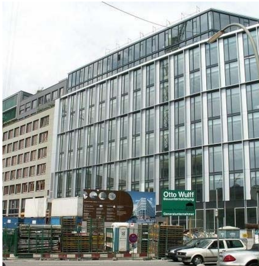
Abbildung 4.1.: Bauwerk – Hohe Bleichen
