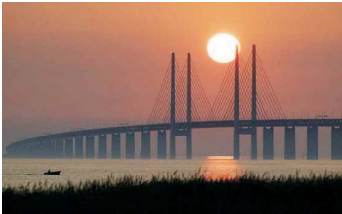
Bild 2.1: Die Öresundbrücke zwischen Dänemark und Schweden [N3]
