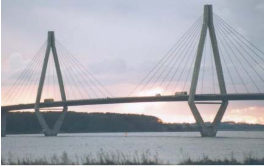
Bild 2.6: Farø-Brücke, Dänemark [I3]
