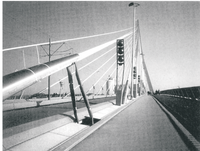
Bild 2.15: Kolbendämpfer (Erasmusbrücke) [R2]
