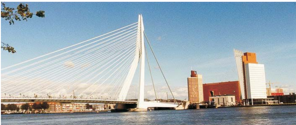
Bild 9.1: Die Erasmusbrücke in Rotterdam (Niederlande)
