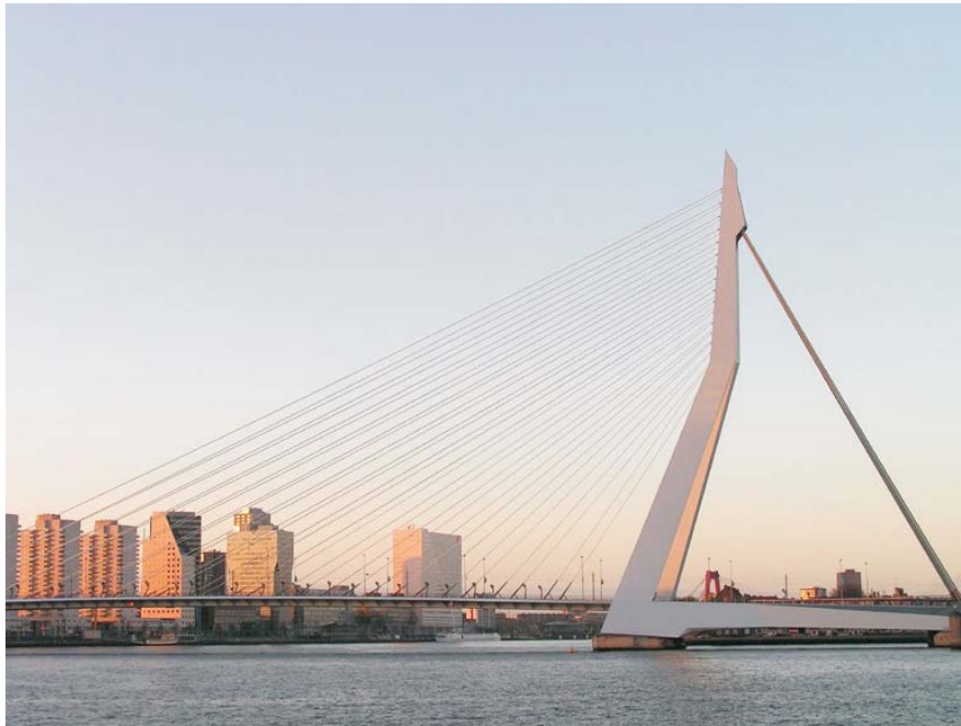
Bild 2.2: Die Erasmus-Brücke in Rotterdam [14]
