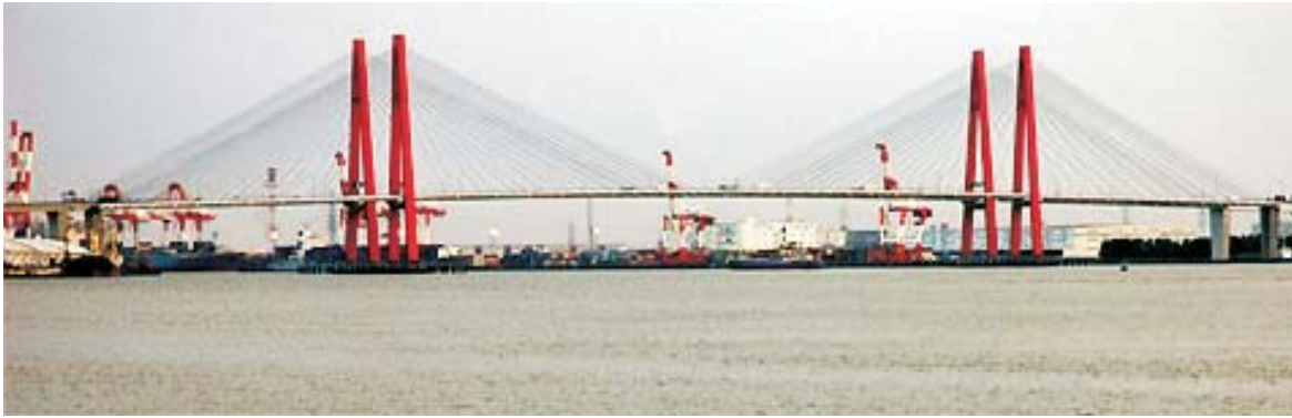
Bild 1.1: Die Meiko-Nishi-Brücke in Japan [14]
