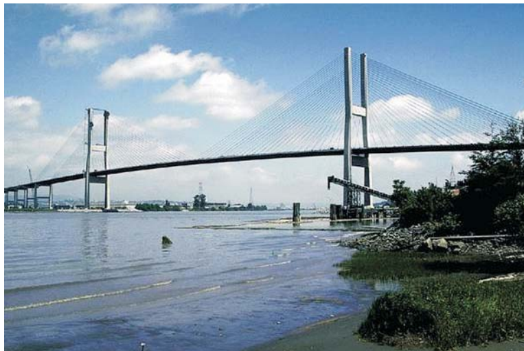
Bild 6.1: Alex-Fraser-Bridge in Kanada [N3]
