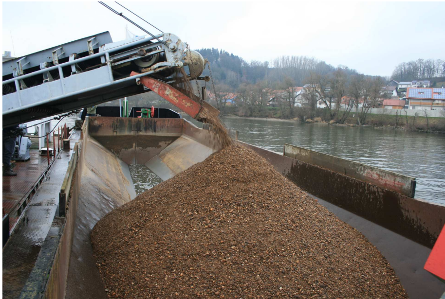
Abbildung 1.3: Baggergut aus einer Unterhaltungsbaggerung beim Befüllen einer Klappschute an der Donau 2008
