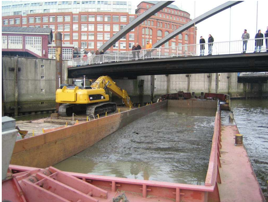
Abbildung 1.2: Feinkörniges Baggergut im Bereich eines Sportboothafens in Hamburg während des Befüllungsvorgangs einer Transportschute, Firma Matthäi 2008
