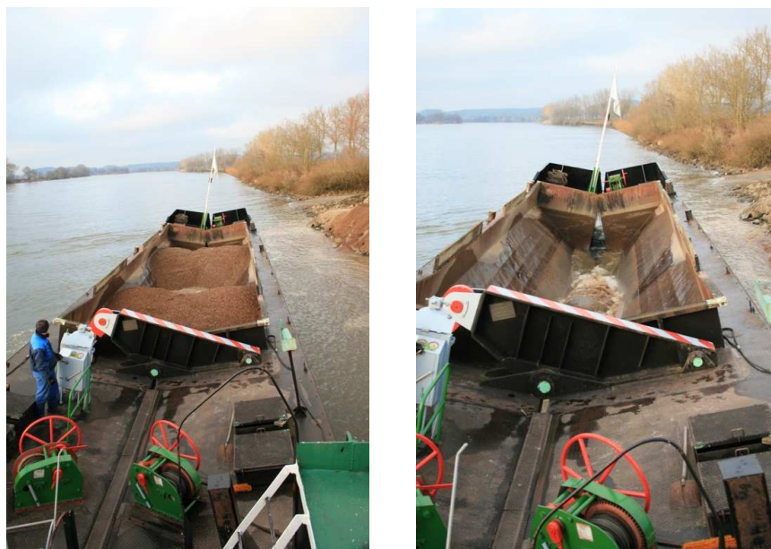
Abbildung 1.5: Verbringen zuvor gebaggerter Sedimente an der Donau aus einer Schute heraus im Dezember 2008
