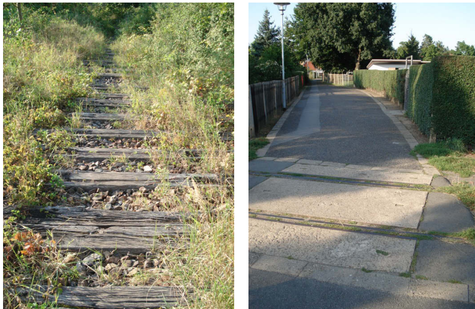
Abbildung 47: Ansicht stillgelegte Bahndammstrecke auf Höhe Waschhausweg – Pirna
