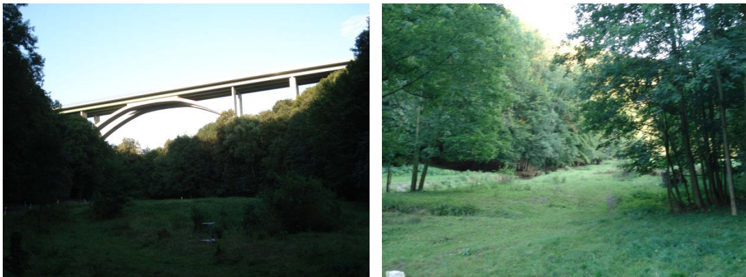
Abbildung 42: Standort des zukünftigen HWRB – li.: Blick auf die Sperrstelle, re.: Blick von der Sperrstelle in den zukünftigen Staubereich
