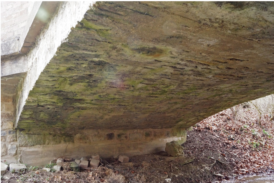
Abbildung 4.53: Die zweite Brücke von Glesse, 1878, Untersicht
