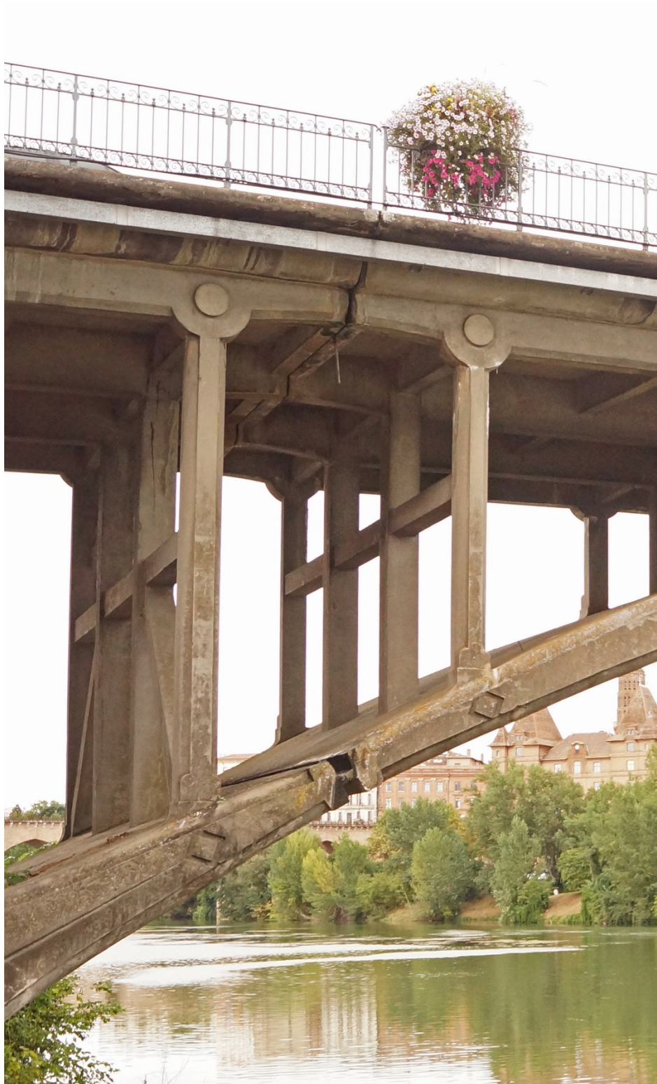
Abbildung 7.77 a-b: Ansicht (vorige Seite) sowie Gelenkdetail des Pont Neuf von Montauban, 1911-1913
