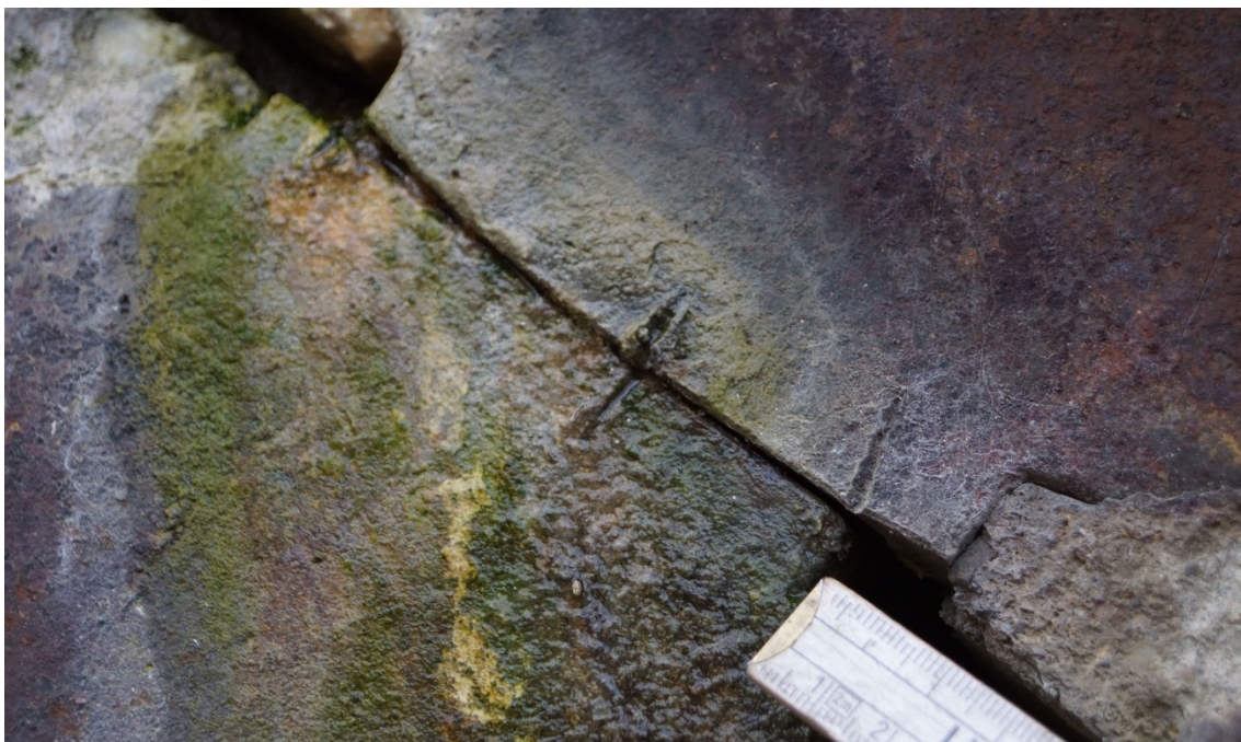
Abbildung 8.53: Detail des Wälzgelenkes mit der Verschiebung der beiden Gelenkhälften, Illerbrücke in Lautrach, 1903–1904
