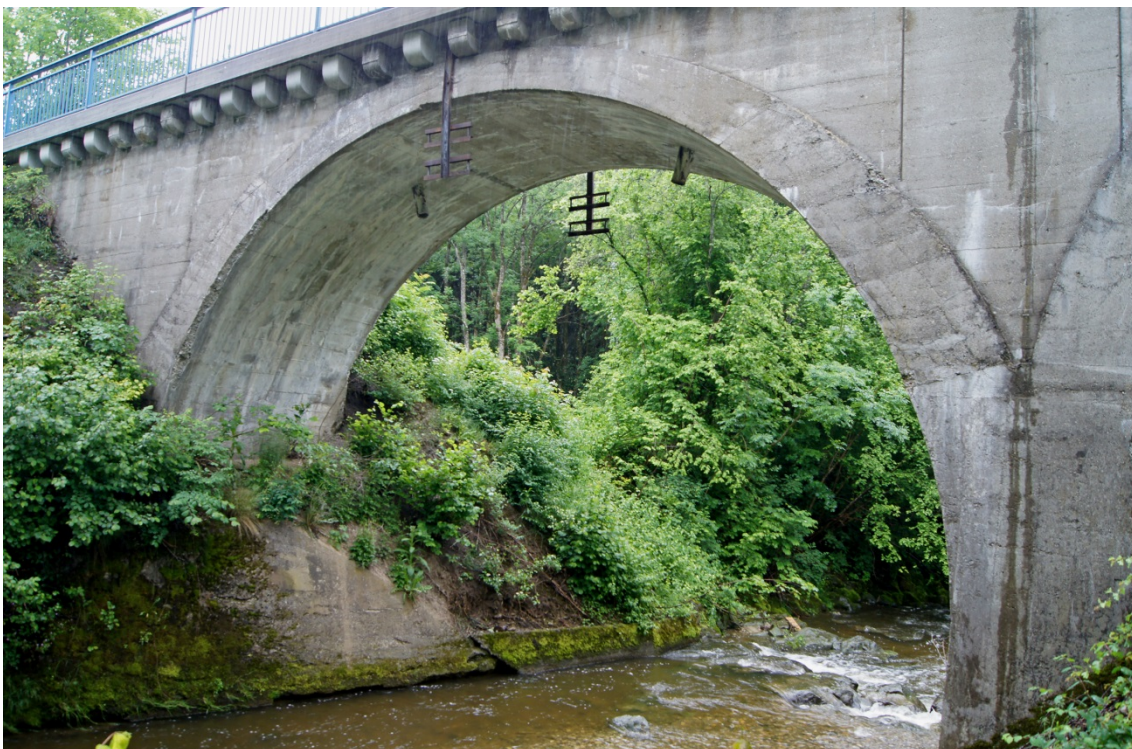
Abbildung 8.23: Die Rottachbrücke in Buchenberg-Ahegg, bei Kempten, 1908 Umbau zum Bahntrassenradweg unter minimalem Eingriff in den Unterbau
