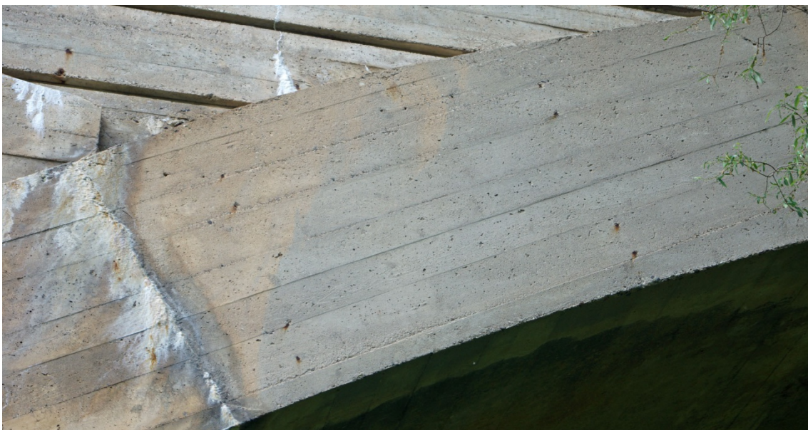
Abbildung 5.54: Spuren der Drahtanker an Bogen und Zwickel der Eisenbahnbrücke in Nürnberg-Schniegling, 1909–1910 (hier der rekonstruierte Teil)
