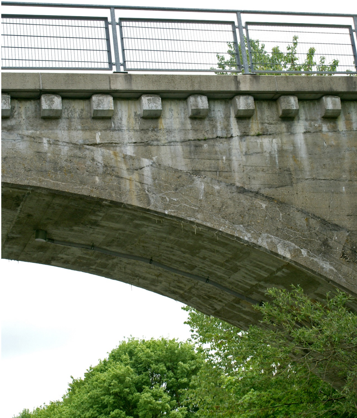
Abbildung 8.7: An der Oberfläche sichtbare Linie der Entwässerung bei einem Vorlandviadukt der Bockerlbrücke in Landau a. d. Isar, 1902
