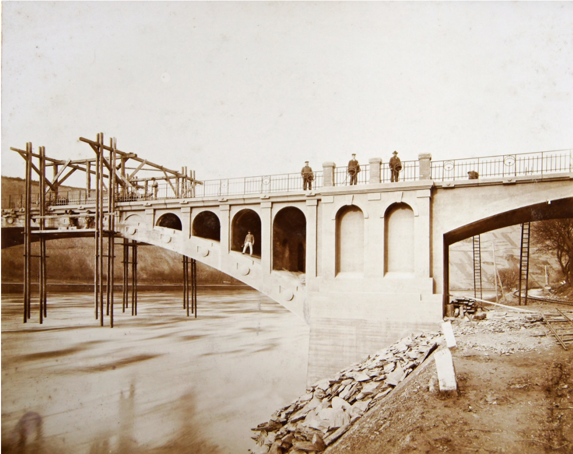
Abbildung 5.97: Nachbearbeitung der Oberflächen mittels eines Arbeitsgerüsts, Moselbrücke, Mehring, 1904–1905 [StadtAHOL, Sign. E.4 Nr. 251]
