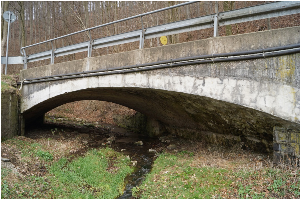
Abbildung 4.55: Die schiefe Brücke von Glesse, genannt „Liebold-Brücke“, 1878, Ansicht
