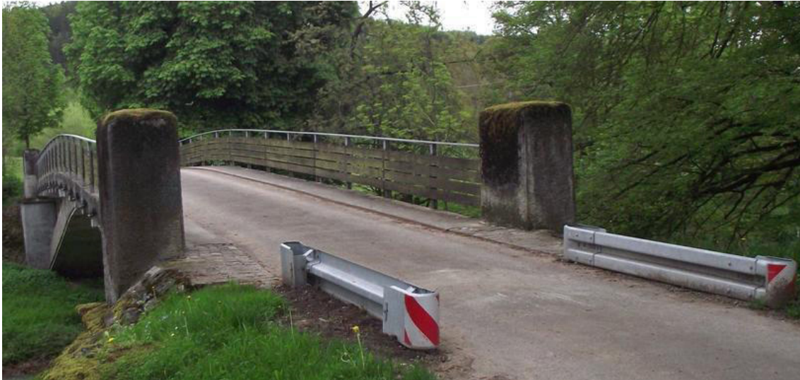
Abbildung 8.35: Leitplanken zur Breitenbeschränkung an der Eyachbrücke in Owingen, 1905 [Selinka 2013]
