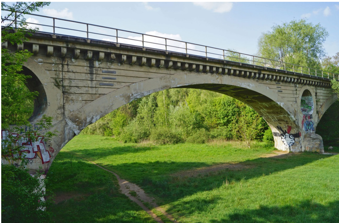
Abbildung 7.38: Eisenbahnbrücke in Nürnberg-Schniegling, 1909–1910
