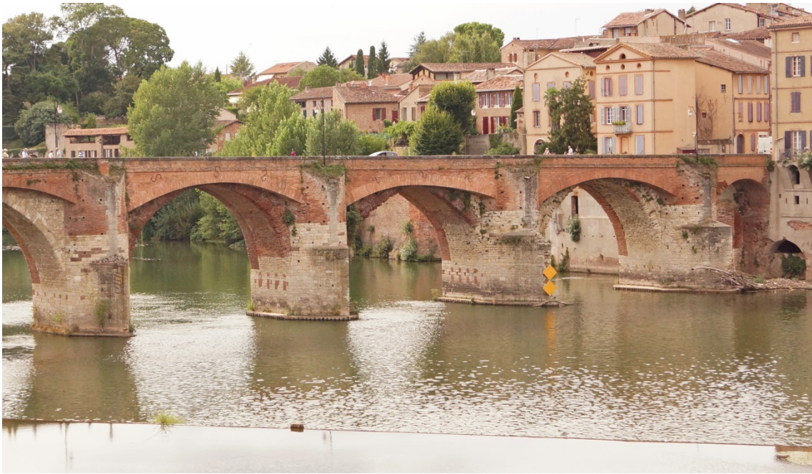
Abbildung 5.25: Zugesezte Balkenlöcher in den Pfeilern des Pont Vieux in Albi, Frankreich
