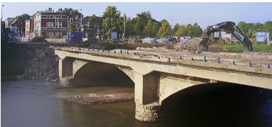
Abbildung 4.65: Abriss der Bodebrücke in Staßfurt, 2013 [Stadt Staßfurt – Der Oberbürgermeister 2013–2014]
