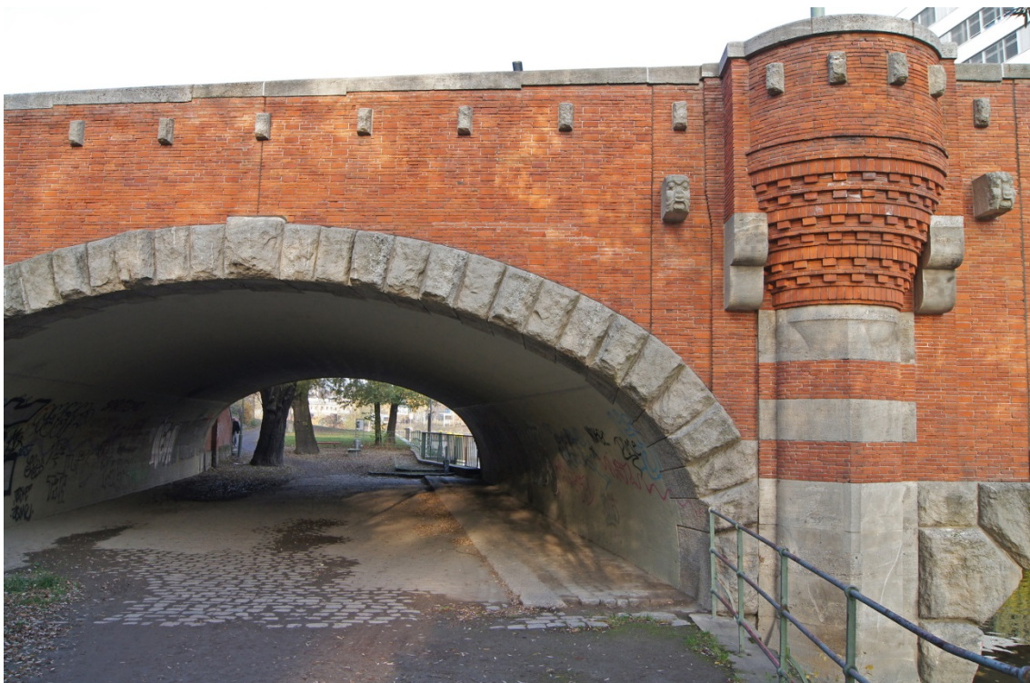
Abbildung 7.30: Ansicht des Nebengewölbes mit Pappkeileinlagen der Dovebrücke, Berlin, 1911
