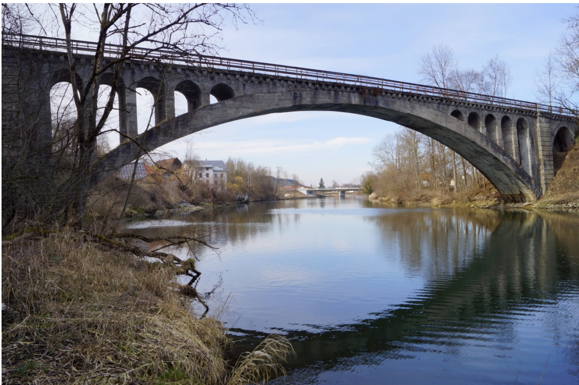
Abbildung 8.36: Die Illerbrücke in Lautrach, 1903–1904; heutiger Zustand
