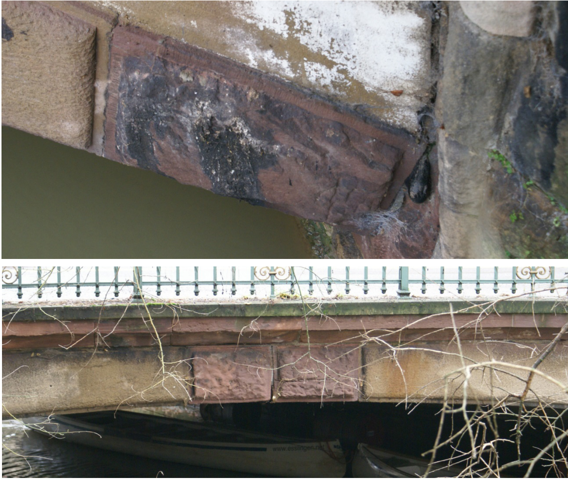
Abbildung 7.90 a–b: Bleigelenke der Hammerkanalbrücke in Esslingen a. N., 1896
