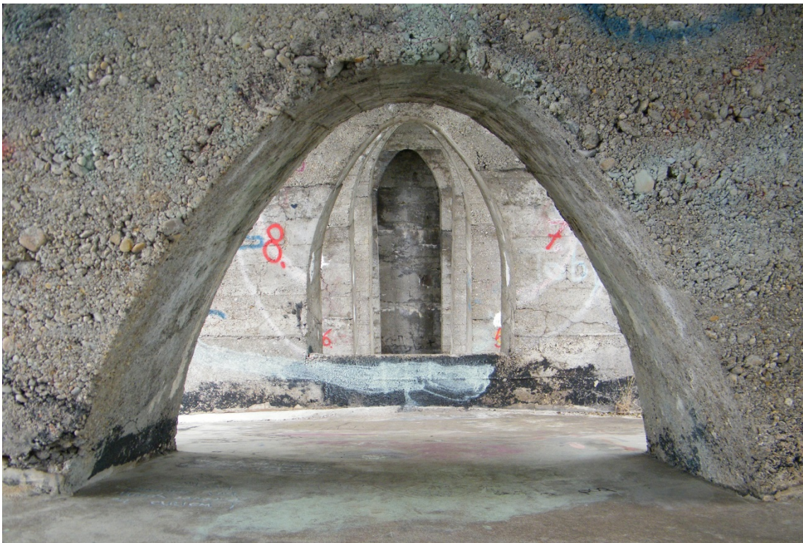
Abbildung 8.22: Beschriftung einer Probenentnahmestelle sowie der verschiedenen Aufständungen (Beschriftung jeweils links und rechts sowie Vorder- und Rückseite) mit rotem Bauspray, Illerbrücke in Lautrach, 1903–1904
