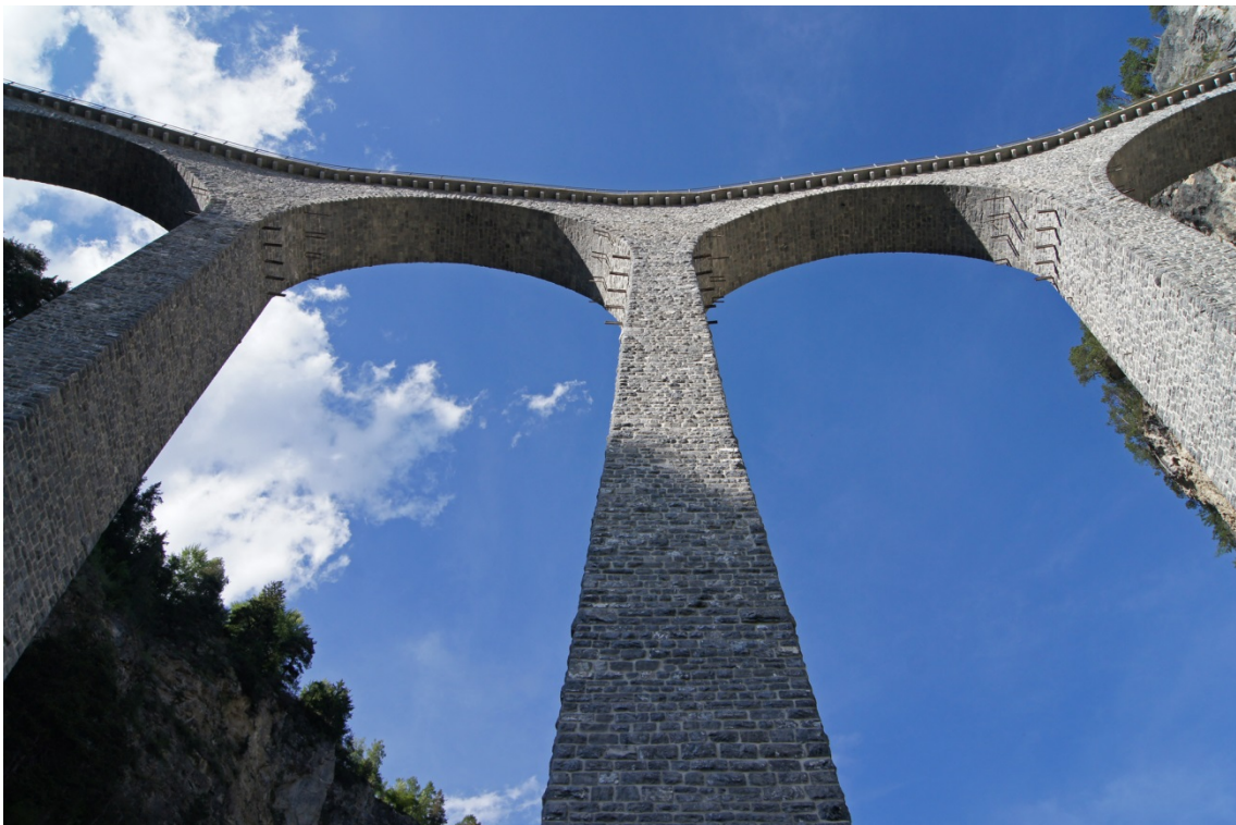
Abbildung 5.21: Heutiger Zustand des Landwasserviaduktes, Filisur, Schweiz, 1901–1902, mit sichtbaren Stahlprofilen der Lehrbogenauflager
