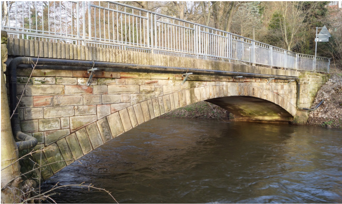
Abbildung 4.63: Ilmbrücke in Bad Berka, 1880
