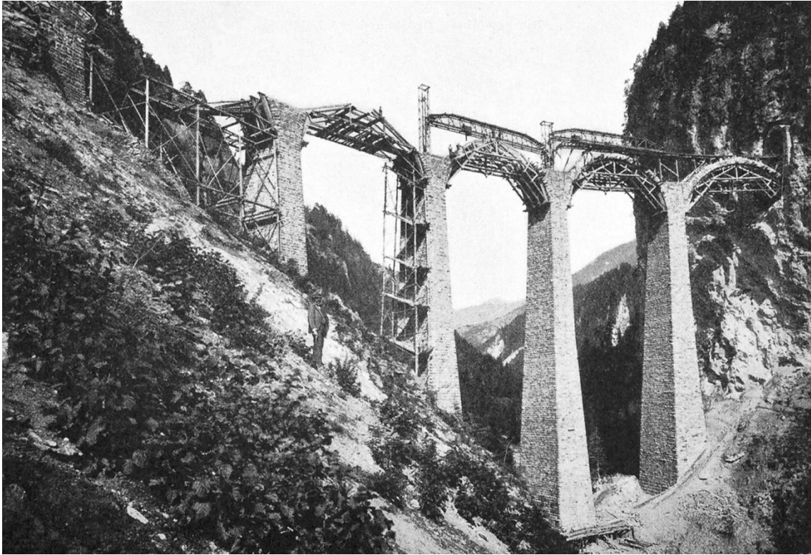
Abbildung 5.20: Bauzeitliche Aufnahme der Lehrbogen des Landwasserviaduktes [N. N. 1904c, S. 47]
