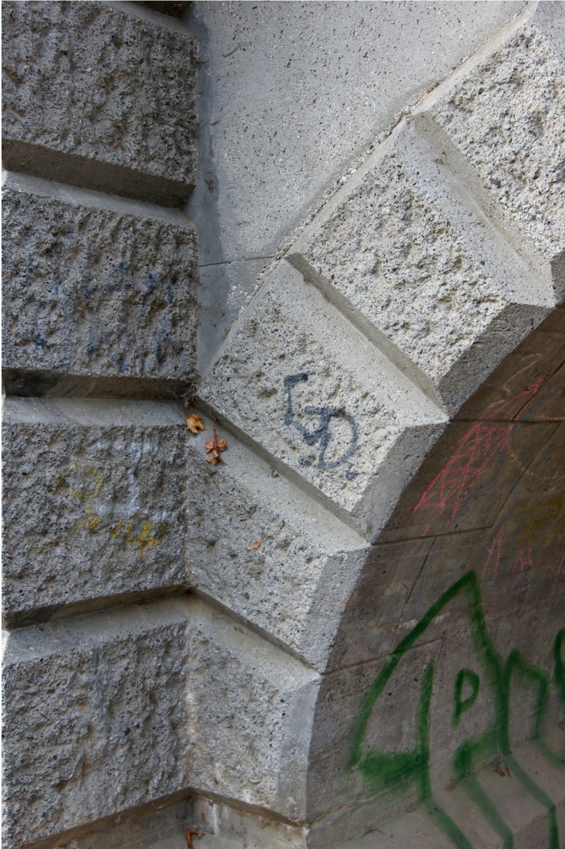
Abbildung 5.87: Steinmetzmäßige Bearbeitung mit dem Spitz Eisen, Leinebrücke, Grasdorf, 1899–1900
