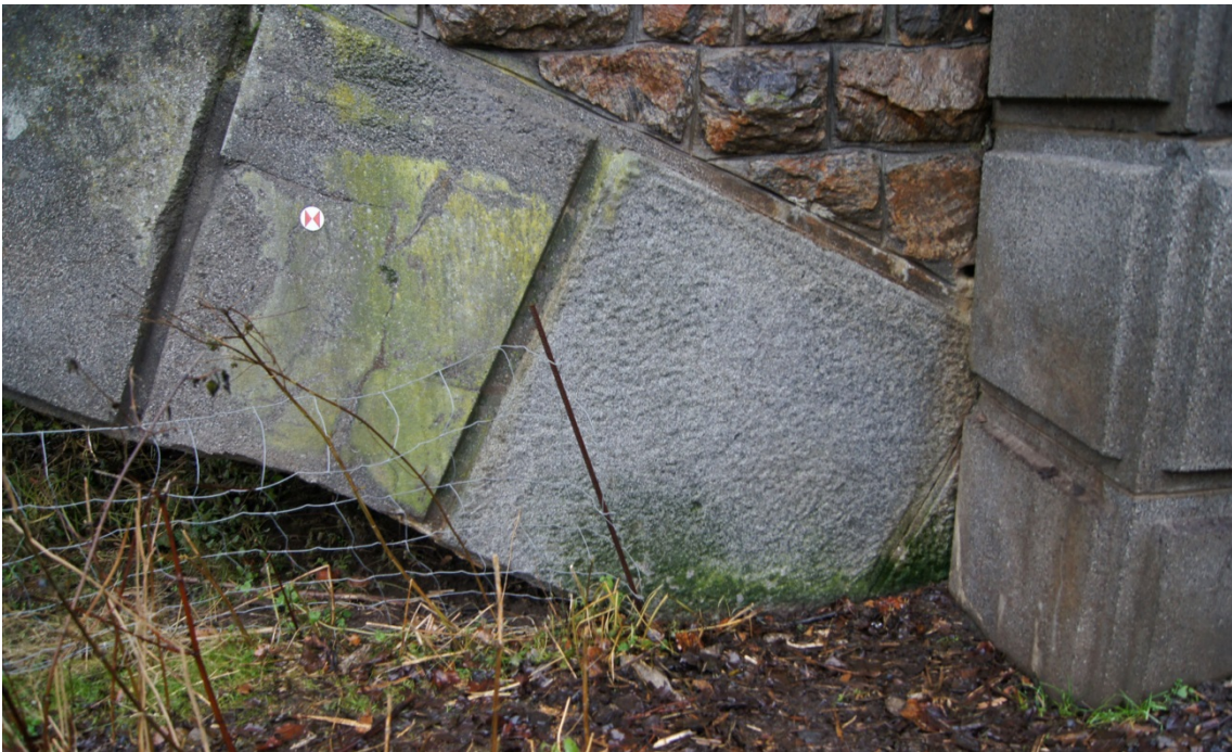
Abbildung 7.48: Ansicht und Gelenkdetail, Muldebrücke, Göhren, 1902
