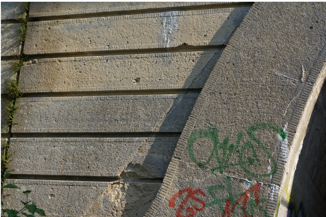
Abbildung 5.86: Steinmetzmäßige Bearbeitung der Oberflächen der Eisenbahnbrücke in Nürnberg-Schniegling, 1909–1910
