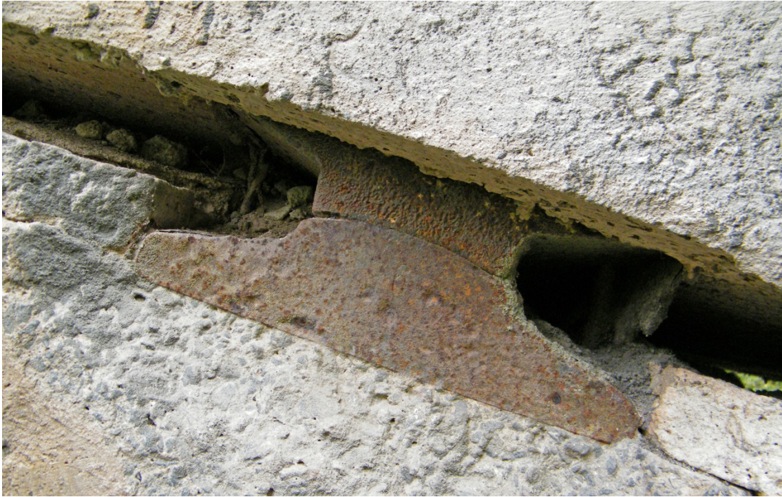
Abbildung 7.59: Wälz Gelenk des Igelsbachviadukts der Wieslaufalbahn, Klaffenbach, 1908–1909
