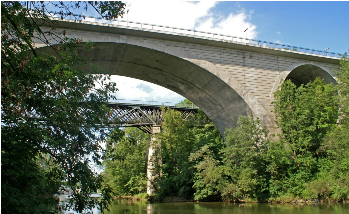
Abbildung 8.13: Verbreiterung der Fahrbahn bei den Illerbrücken in Kempten, 1903–1906
