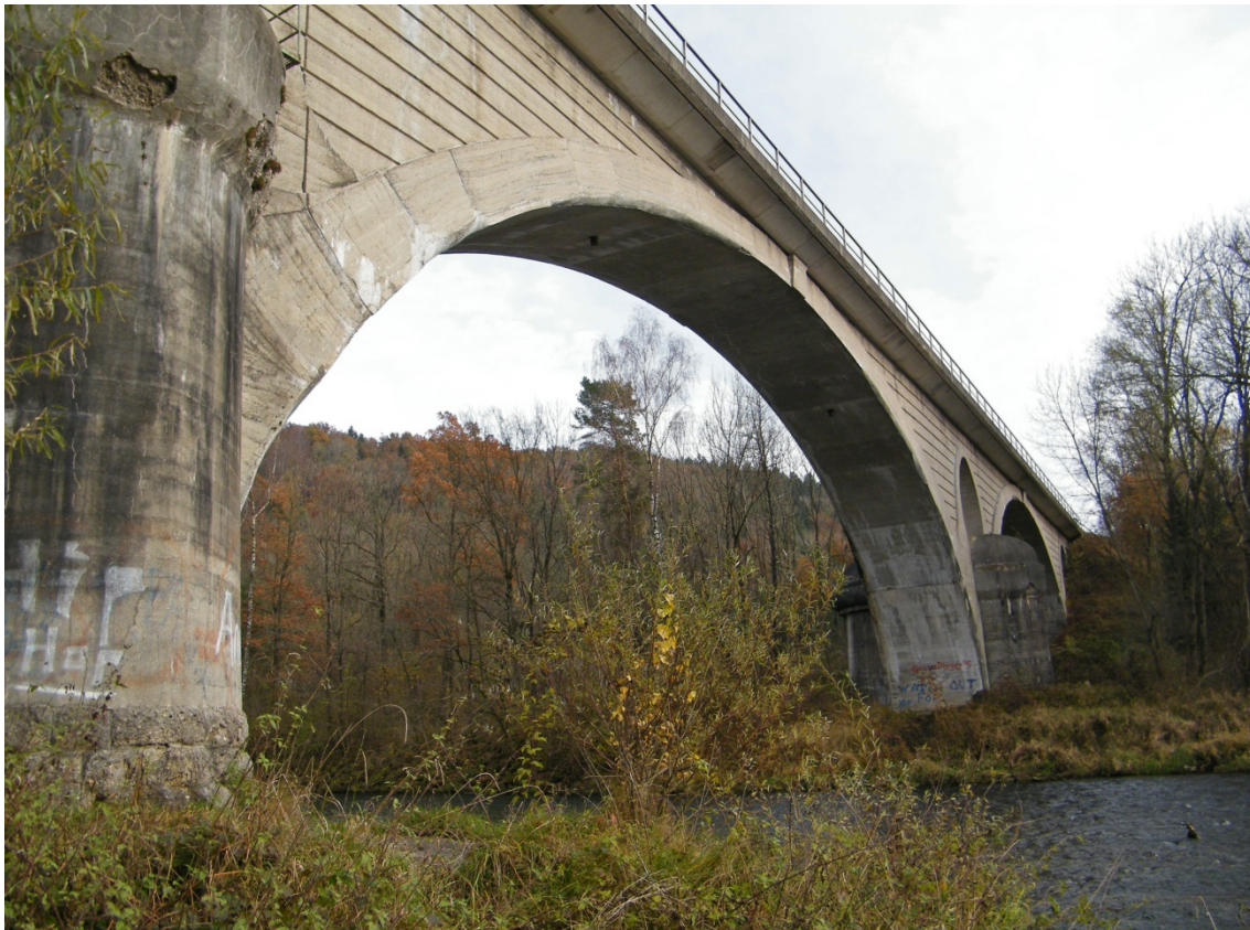
Abbildung 7.35: Eisenbahnbrücke bei Garching a. d. Alz, 1907–1908
