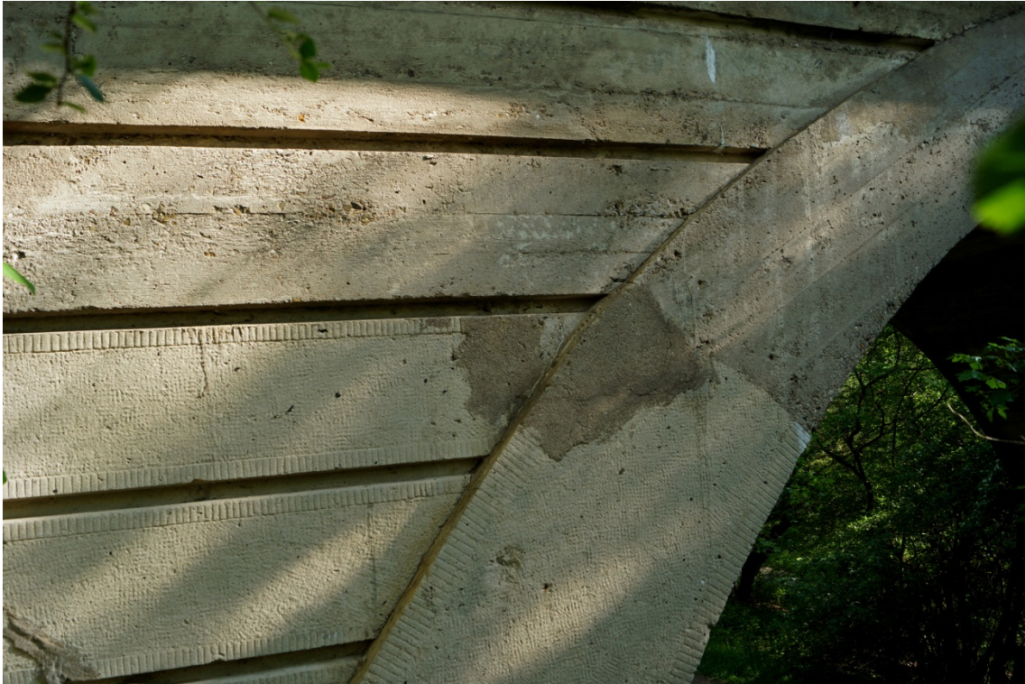
Abbildung 8.26: Zweite Baufuge der Pegnitzbrücke in Nürnberg-Schniegling, 1909–1910
