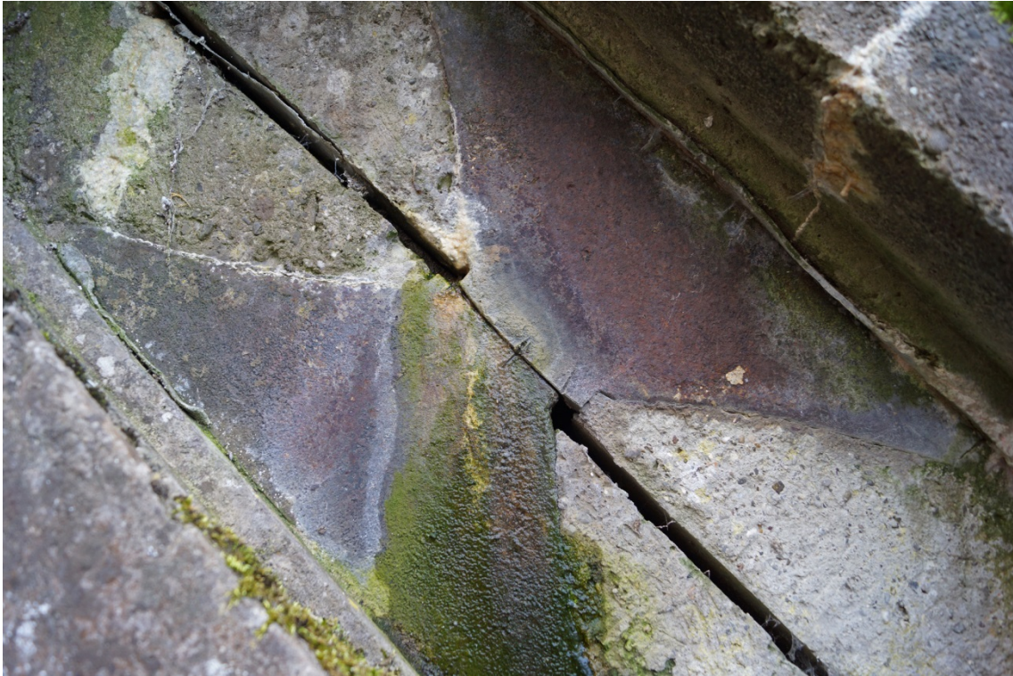
Abbildung 8.50: Ansicht des Kämpfergelenkes, sichtbare Blei- und Asphaltlagen, Illerbrücke in Lautrach, 1903–1904
