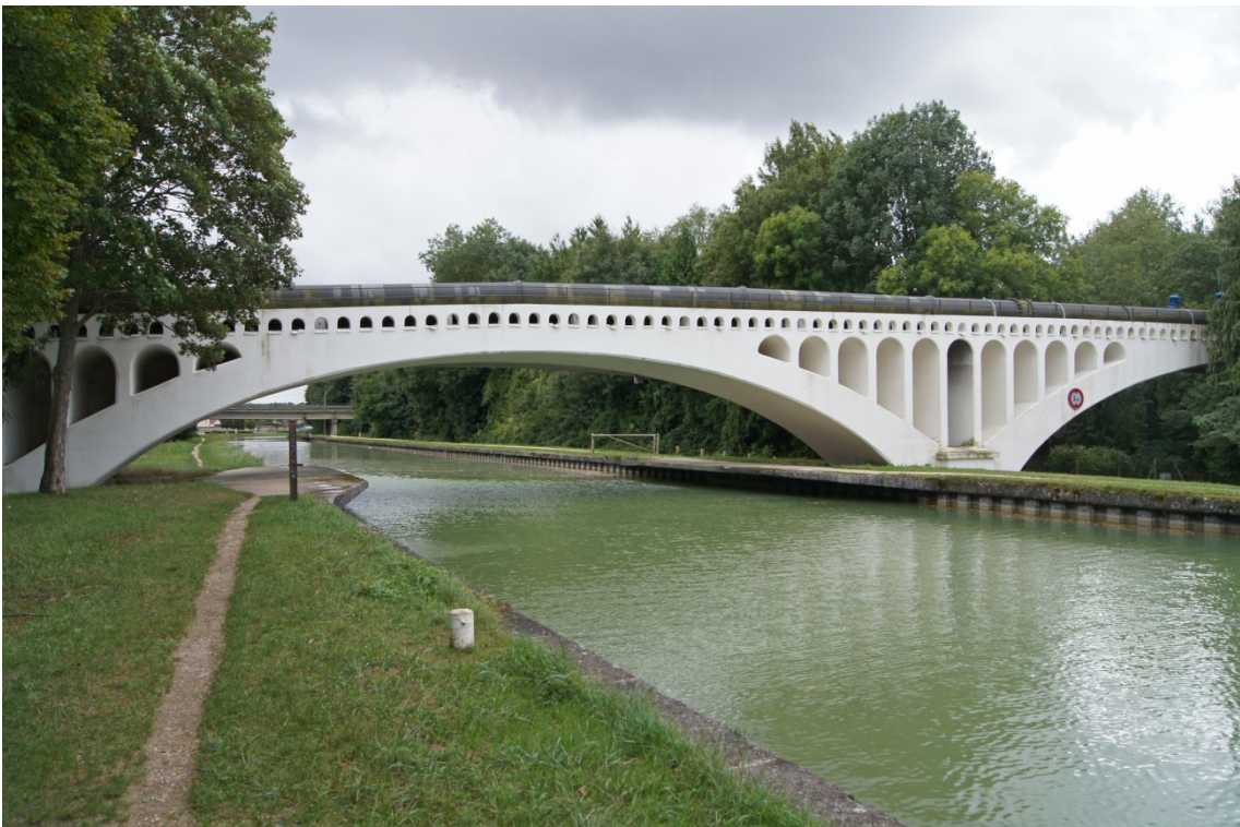
Abbildung 8.8 a–b: Vollflächige Überarbeitung der Oberflächen bei den Bauwerken im Wald von Fontainebleau sowie bei Moret-sur-Loing, Vanne-Aquädukt, Frankreich, 1867–1874
