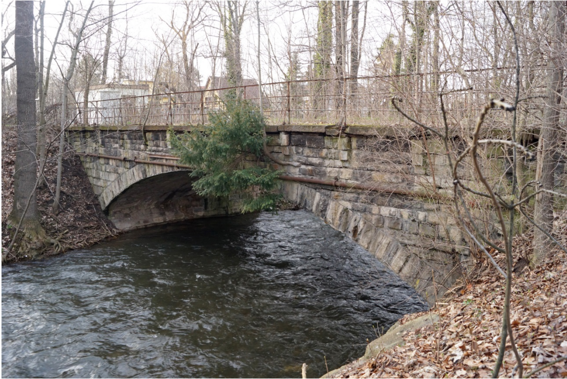
Abbildung 4.61: Gerabrücke in Arnstadt, 1880
