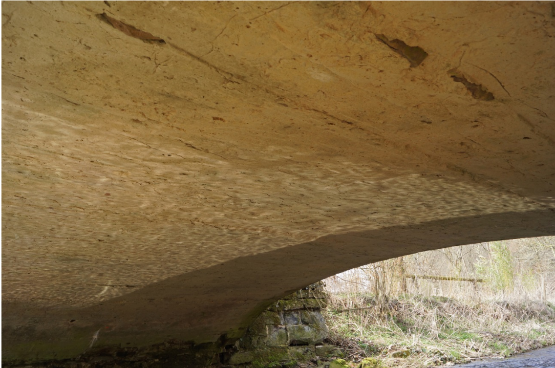
Abbildung 4.47: Intrados der Lennebrücke in Vorwohle, 1877. Im oberen Bereich des Bildes sind Spuren der Kalksteinplatten sichtbar
