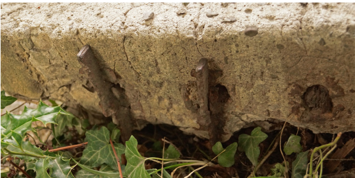
Abbildung 4.17: Detailaufnahme der Stabenden mit Keilverspannungen an der Vicat-Brücke in Grenoble, Frankreich, 1855
