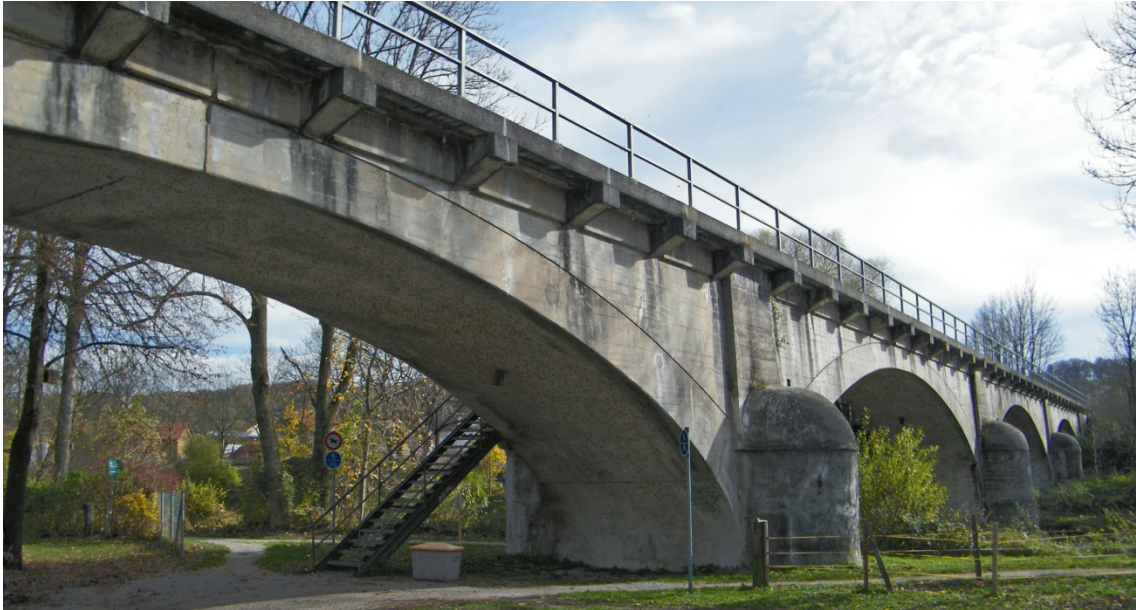
Abbildung 8.31: Eisenbahnbrücke in Trostberg a. d. Alz, 1910
