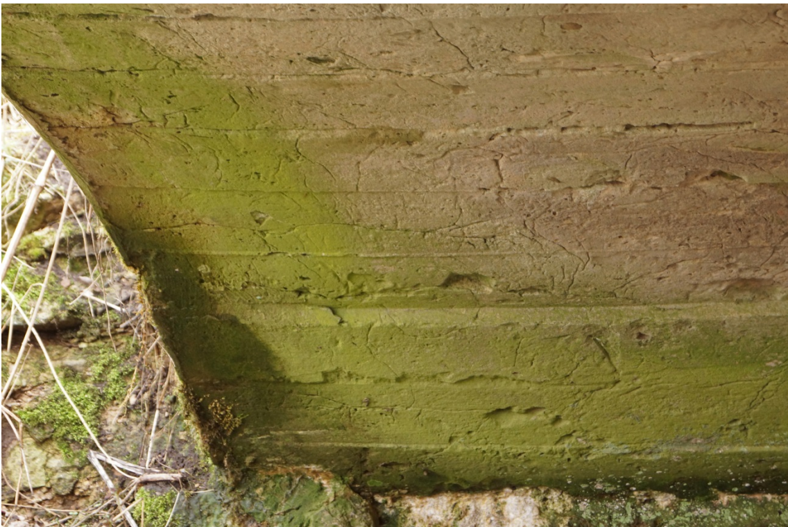
Abbildung 4.48: Intrados der Lennebrücke in Vorwohle, 1877. Schalbretttabdrücke und Netzmuster als Spuren des Herstellungsprozesses
