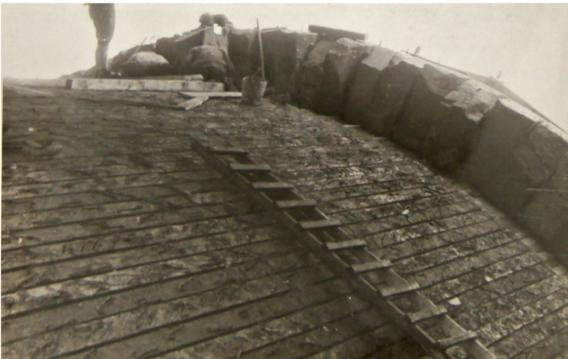
Abbildung 5.48: Schalung mit geringem Abstand für Betonbogen, Altenbeken, 1950 [StadtAHOL, Sign. E.4 Nr. 138]
