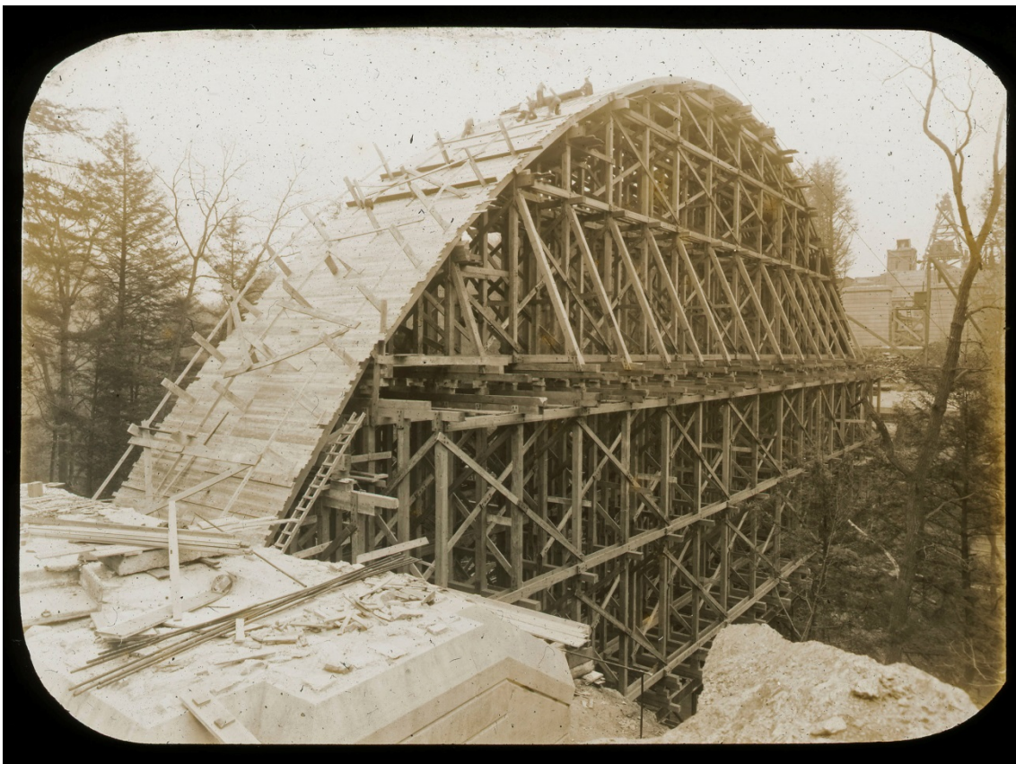
Abbildung 5.33: Ständersystem beim Lehrgerüst der Walnut Lane Bridge, Philadelphia, USA, 1906–1908
