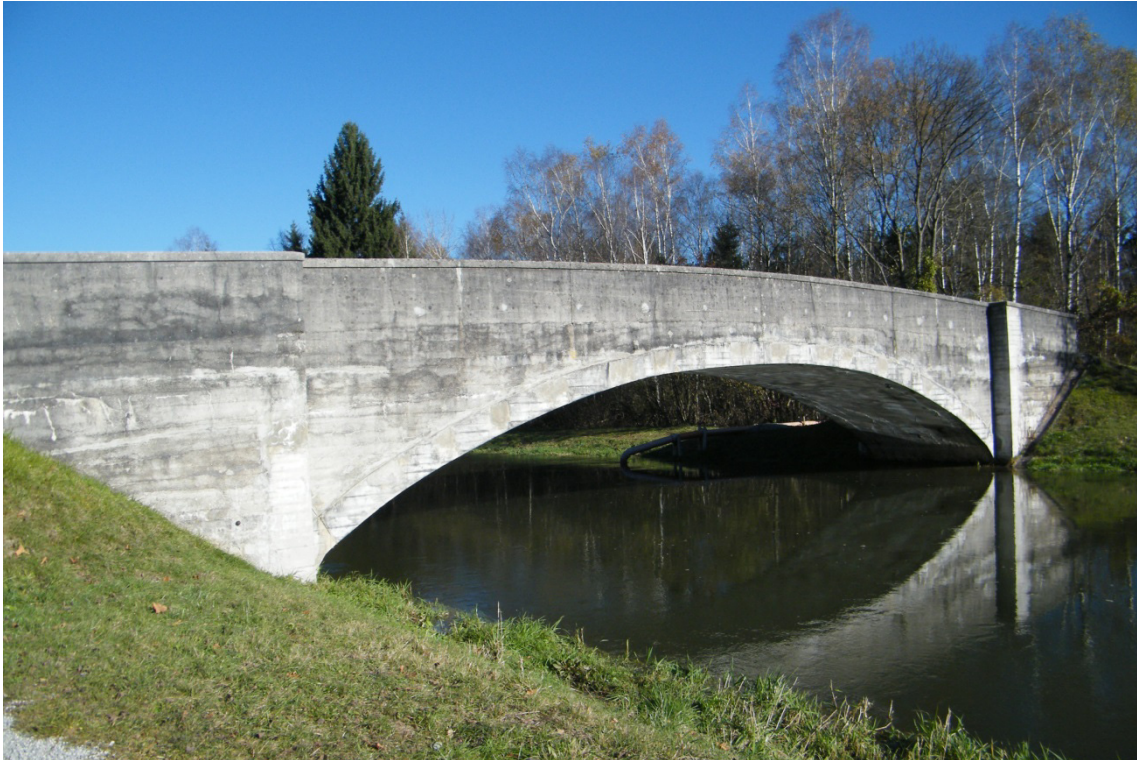
Abbildung 8.18: Wolfratshausen-Gelting: Brücke mit Betonbrüstungen und Sichtbetonoberflächen
