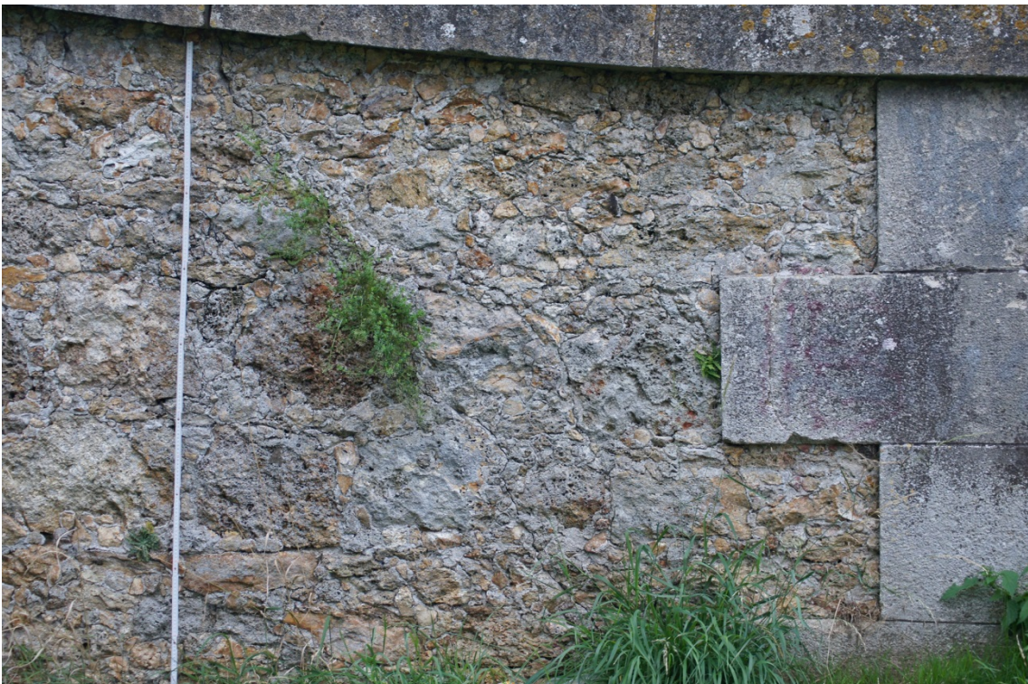
Abbildung 4.19: Detailansicht des Bruchstein-Zement-Betons der Dhuys-Aquäduktbrücken bei Montry, Frankreich, 1863–1865
