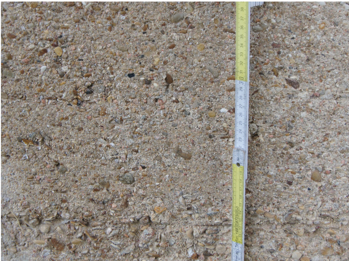
Abbildung 4.21: Detailaufnahme der Betonzusammensetzung am Aquäduktbauwerk bei Villeperrot, Frankreich, 1872
