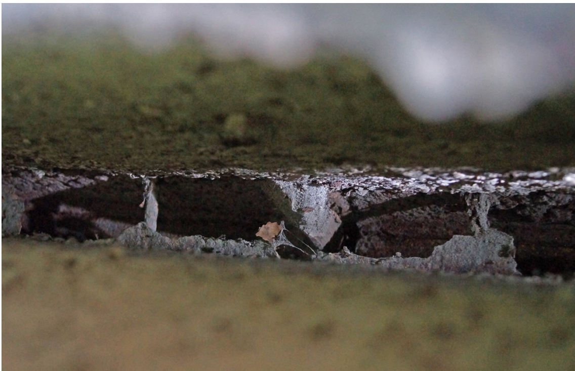
Abbildung 7.61 a-b: Igelsbachviadukt der Wieslaufalbahn, Klaffenbach, 1908-1909: Wälzgelenks mit Bolzen a) Blick auf das Gelenk mit Bolzen b) Blick von unten in die Gelenkfuge
