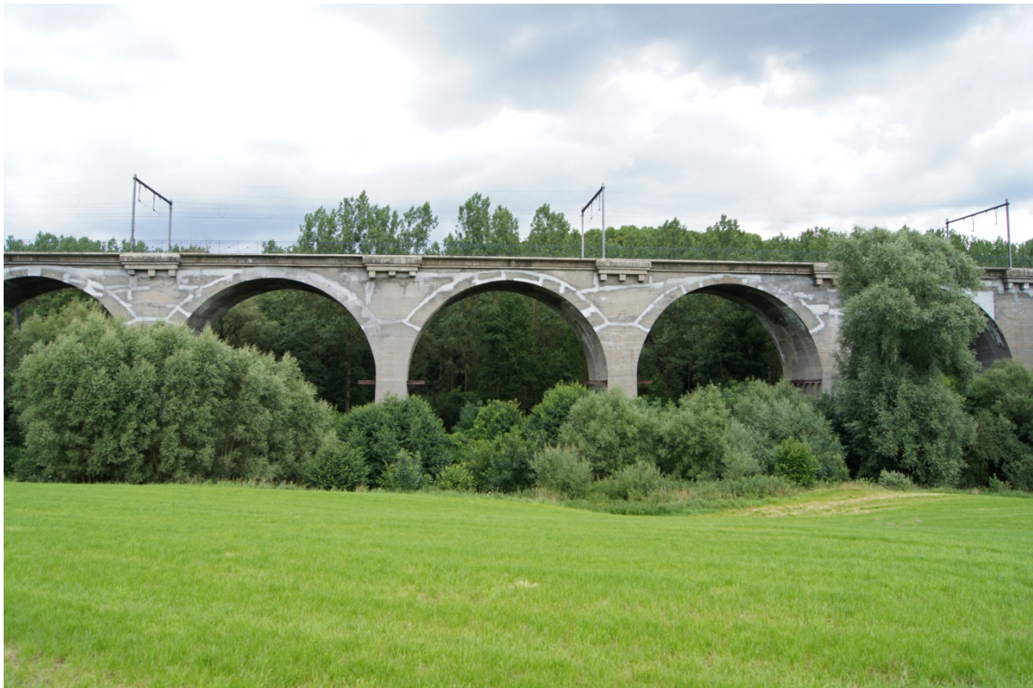
Abbildung 5.22: Der Eisenbahnviadukt bei Remersdaal, Belgien, 1916
