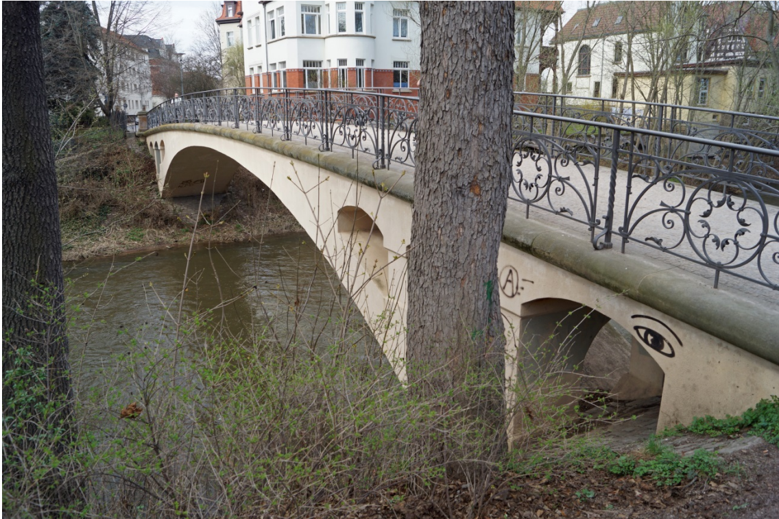
Abbildung 8.11: Vollflächige Oberflächenbearbeitung beim Wilhelm-Steg in Erfurt, 1898
