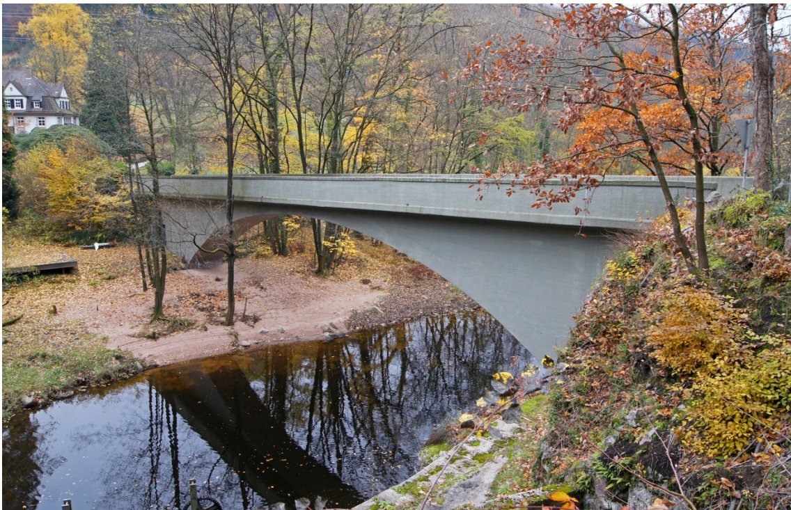
Abbildung 8.12: Vollflächige Oberflächenbearbeitung bei der Zufahrtsbrücke zur Fabrikantenvilla in Langenbrand, 1910
