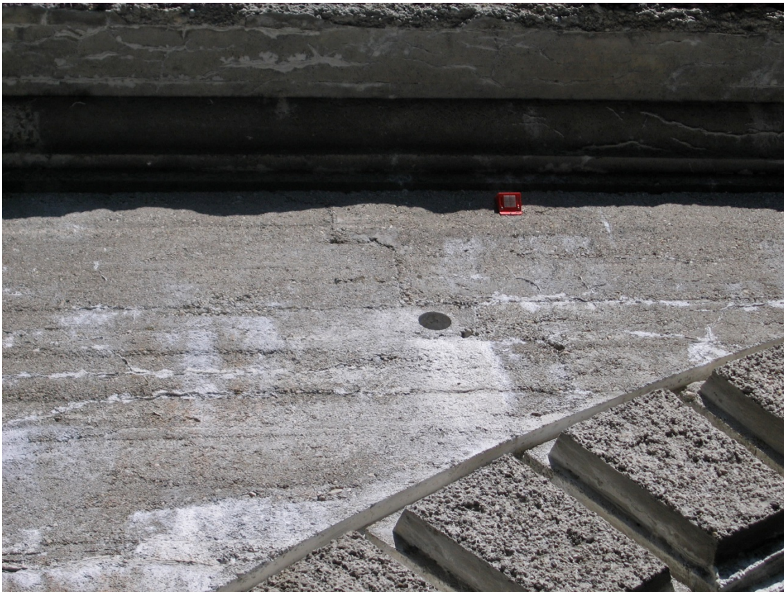
Abbildung 5.84: Betonierabsatz am Teufelsgrabenaquädukt in Grub, Valley, 1890
