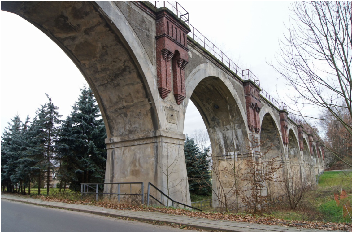
Abbildung 7.20 a–b: Viadukt in Niedersteinbach sowie Gelenkdetail (linke Seite) Bahnlinie Altenburg–Langenlauba–Oberhain, 1899–1901
