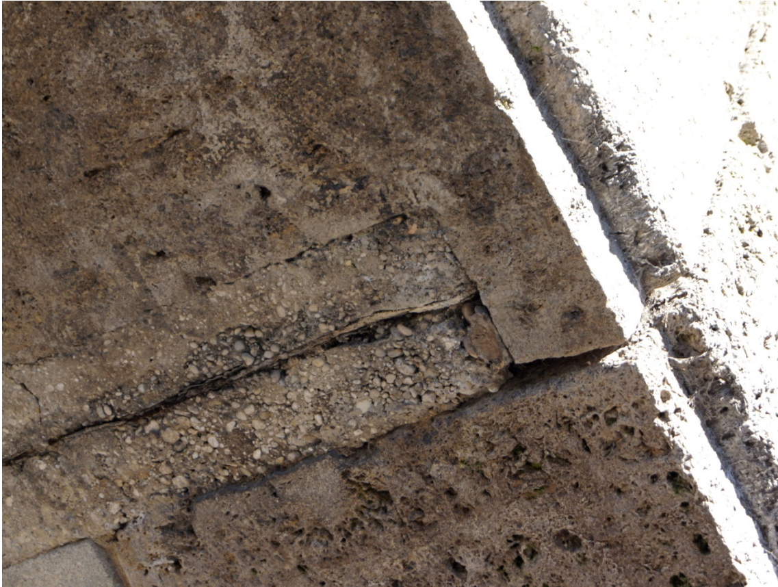
Abbildung 7.15: Untersicht des Gelenkes der Maximiliansbrücke, München, 1903–1905: Gut sichtbar ist hier der ausgeklinkte Stein der Verkleidung, der die Gelenkfuge verdeckt
