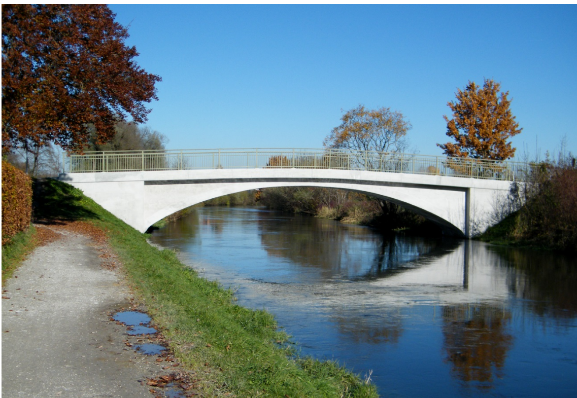
Abbildung 8.19: Wolfratshausen-Gelting am Bahnweg: Überarbeitete Schwesterbrücke des in Abbildung 8.18 dargestellten Bauwerks
