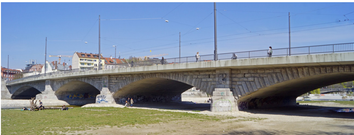
Abbildung 8.14: Fahrbahnverbreiterung der Reichenbachbrücke in München, 1902
