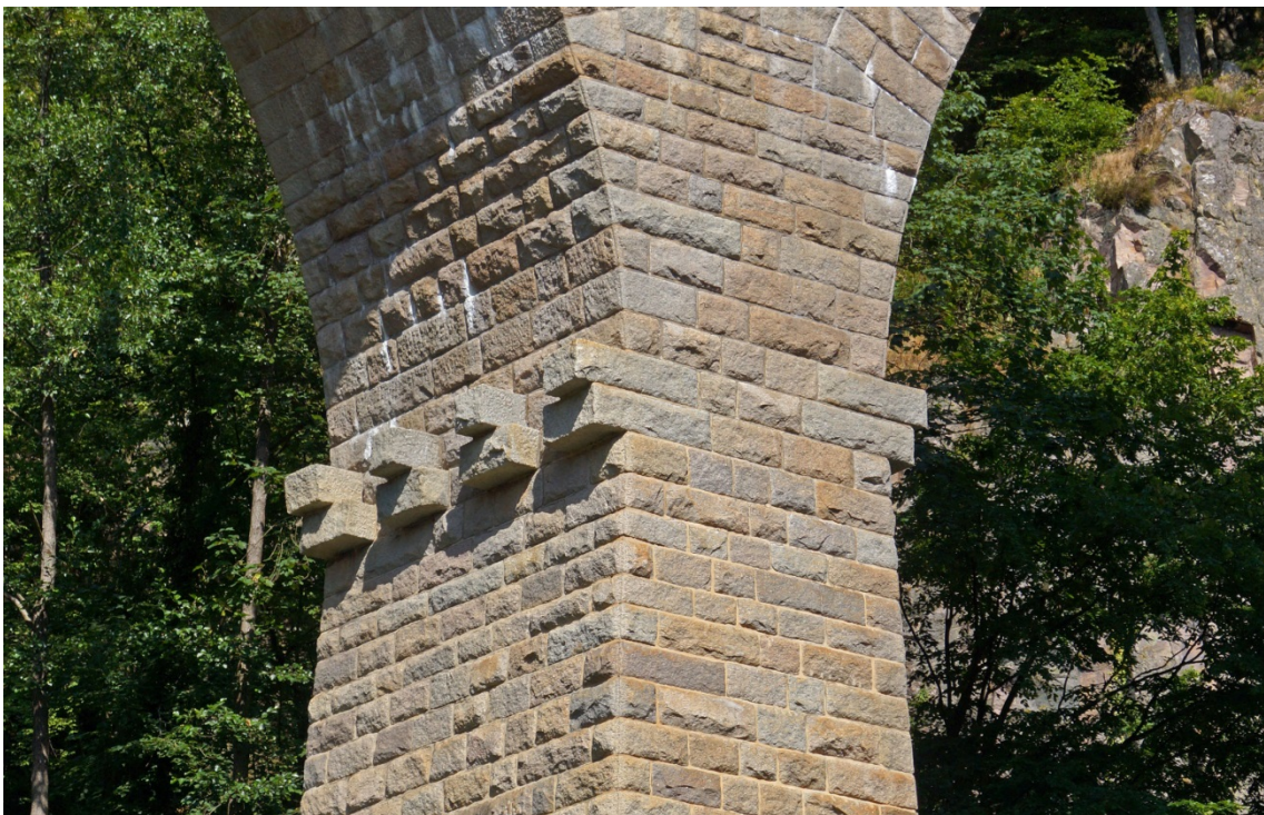
Abbildung 5.14: Tragsteine am Viadukt über die Tennetschlucht zwischen Langenbrand und Forbach im Schwarzwald, 1808–1809
