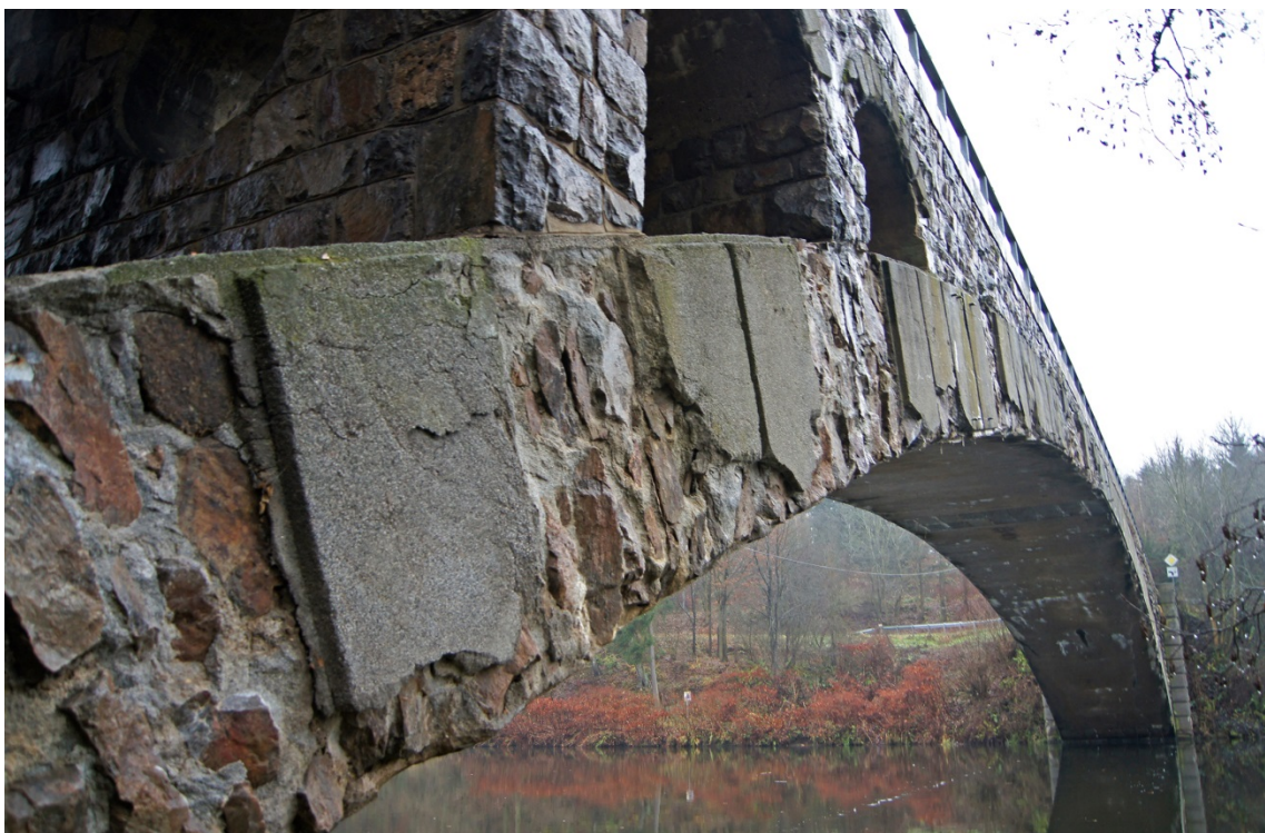
Abbildung 5.92: Vergleichbare Situation wie in Abbildung 5.90 dargestellt, jedoch ohne Anker, Muldebrücke, Göhren, 1902
