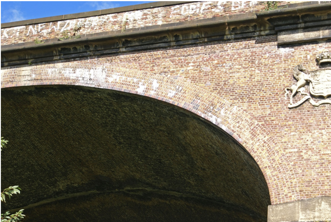
Abbildung 6.17: Wharncliffe Viaduct bei Hanwell, Great Western Railway, Großbritannien, 1836–1837
