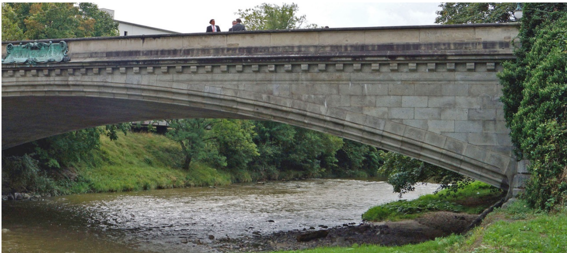
Abbildung 7.16: Detailansicht des Bogens der Stauffacher-Brücke, Zürich, Schweiz, 1899
