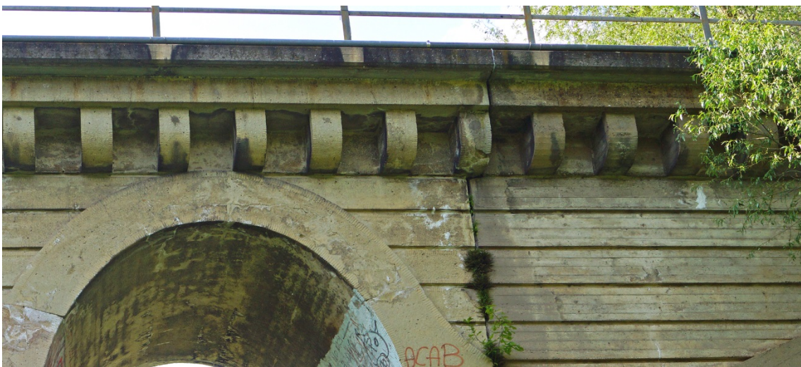
Abbildung 8.27: Konsolen im Übergang von Original und Rekonstruktion an der Pegnitzbrücke in Nürnberg-Schniegling, 1909–1910
