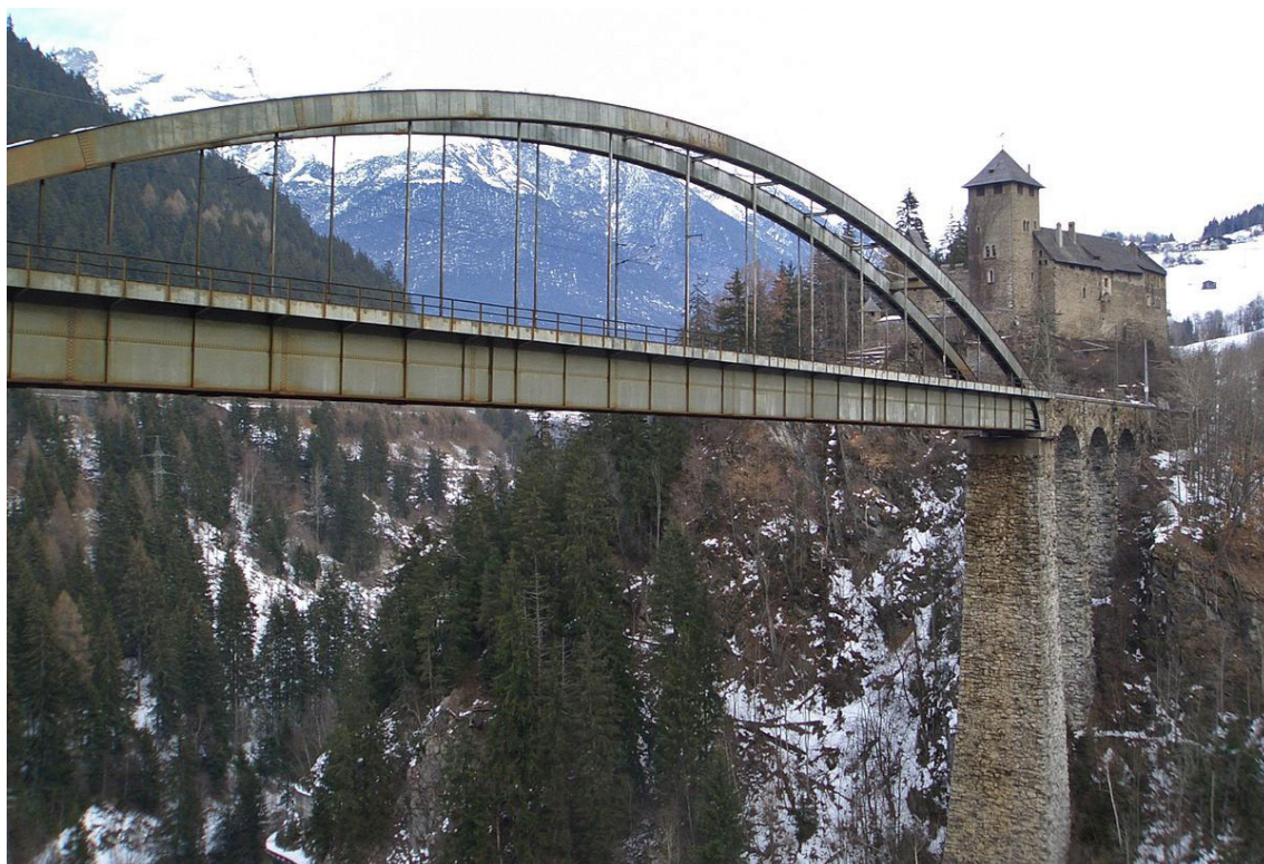
Abbildung 8.2: Der Neubau der Trisannabrücke, 1964
