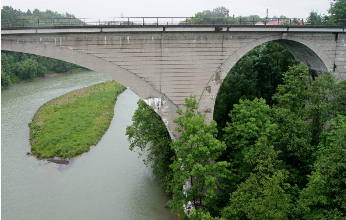
Abbildung 7.17: Nach innen versetzte Gelenke bei den Illerbrücken in Kempten, 1903–1906
