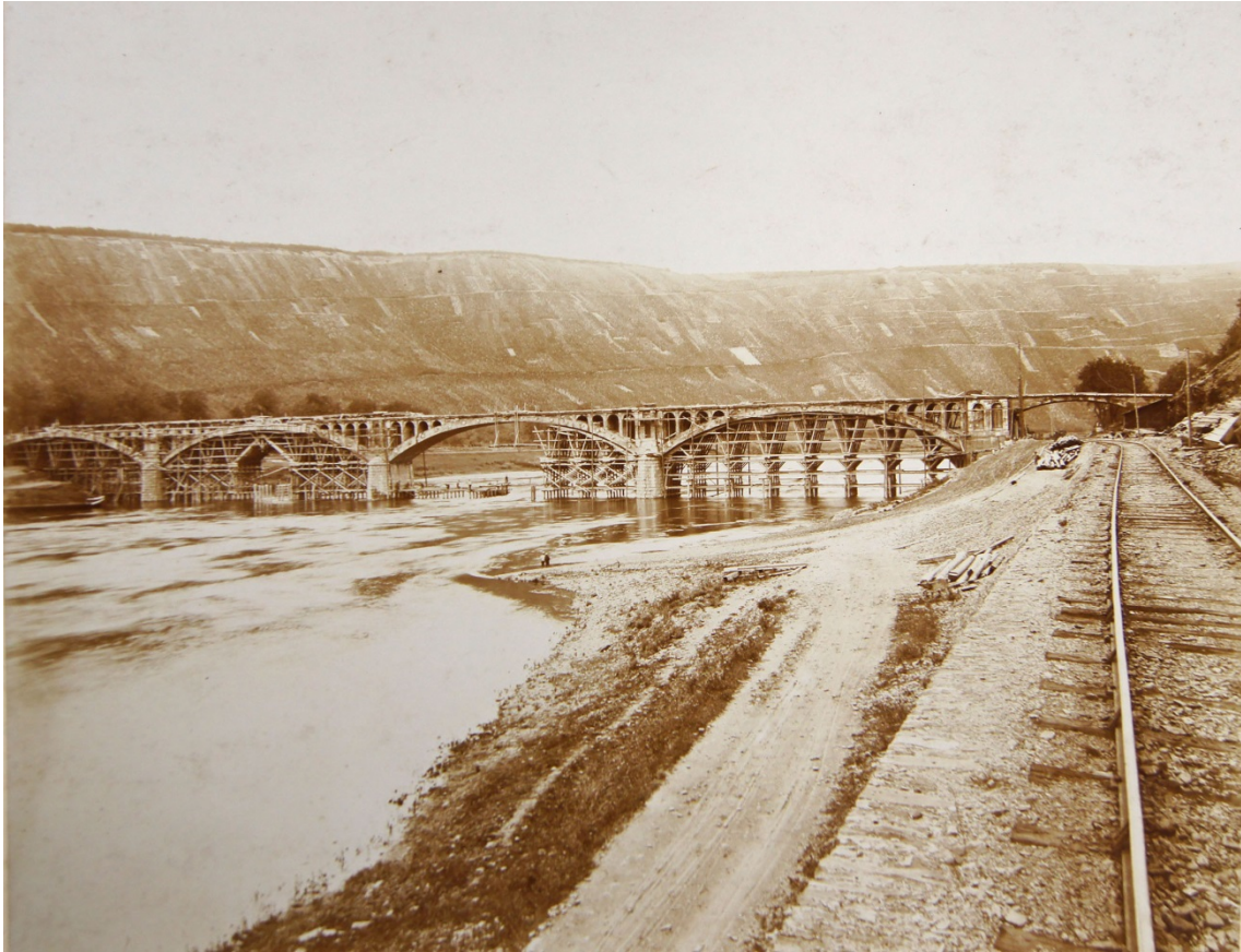
Abbildung 5.59: Moselbrücke Mehring, 1904–1905 [StadtAHOL, Sign. E.4 Nr. 13]
