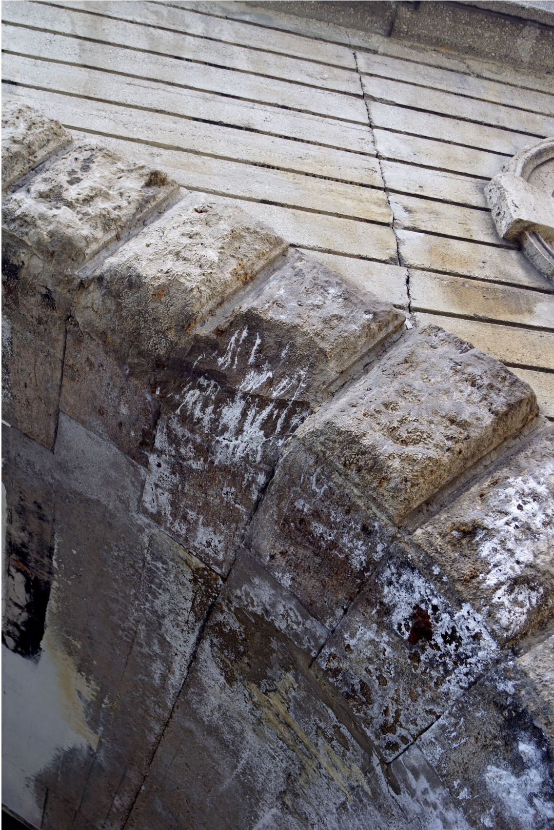
Abbildung 7.24: Detail eines Rampenbogens der Hackerbrücke in München, 1891
