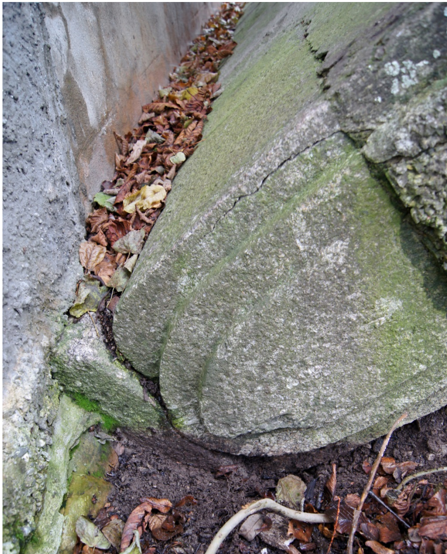
Abbildung 7.42 a-b: Ansicht sowie Detail des Granitgelenkes im Kämpfer der Eyach-Brücke, Owingen, 1905
