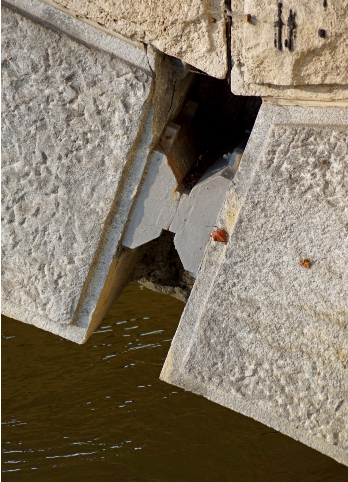
Abbildung 7.58: Zweiteiliges, inzwischen überstrichenes Gelenk der Corneliusbrücke, München, 1901–1903
