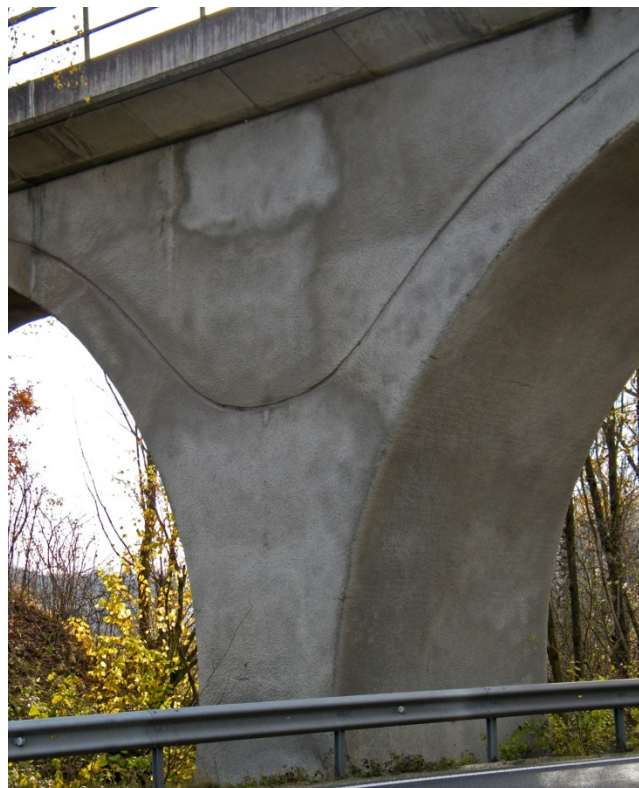
Abbildung 8.10: Schwesterbrücke zu dem in Abbildung 8.9 dargestellten Bauwerk mit vollflächigem Verputz, Garching a. d. Alz, 1907–1908
