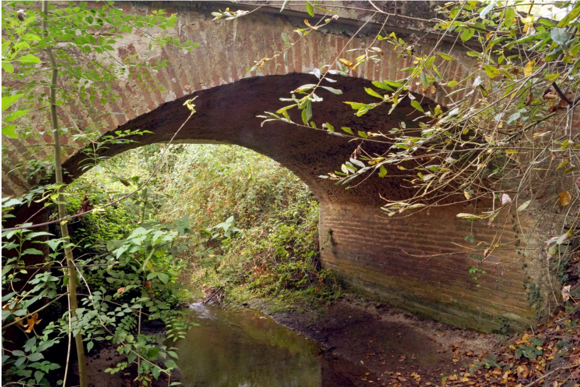
Abbildung 4.10: Betonbrücke von Villemade, Frankreich, 1835 Ansicht der Brücke mit Ziegelverblendungen
