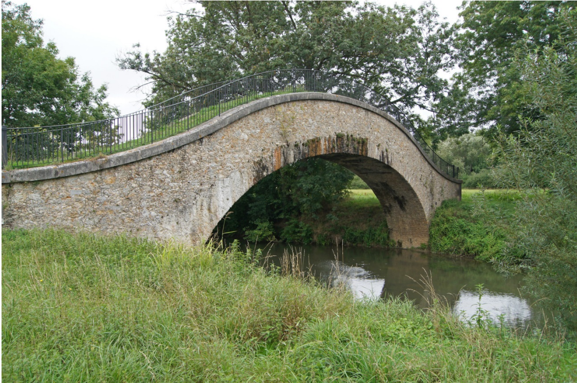
Abbildung 4.18: Eine der Beton-Aquäduktbrücken der Dhuys-Wasserleitung bei Montry, Frankreich, 1863–1865
