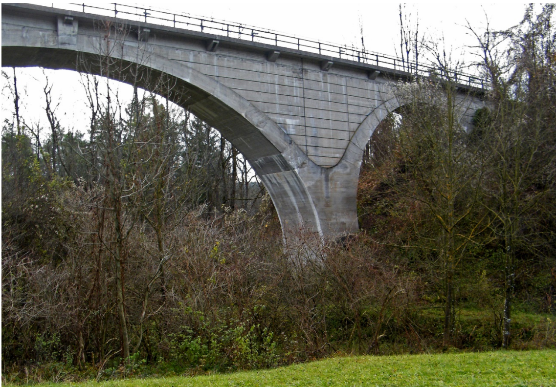
Abbildung 8.9: Ansicht einer sich zumindest im Unterbau im Originalzustand befindenden Brücke der Bahnlinie Mühldorf–Freilassing, Garching a. d. Alz, 1907–1908
