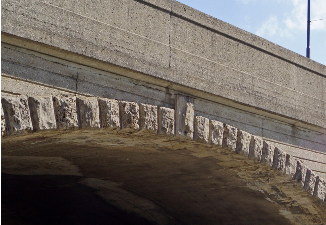
Abbildung 8.29: Rampenbogen der Hackenbrücke, München, 1891, mit bauzeitlich eingeplanten Bewegungsfugen in der Nähe des Scheitels und im Kämpferbereich
