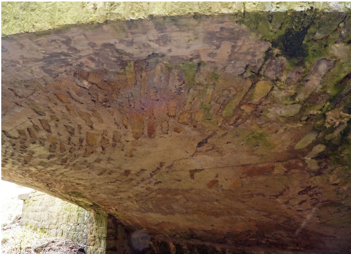
Abbildung 4.56: Die schiefe Brücke von Glesse, genannt „Liebold-Brücke“, 1878, Untersicht
