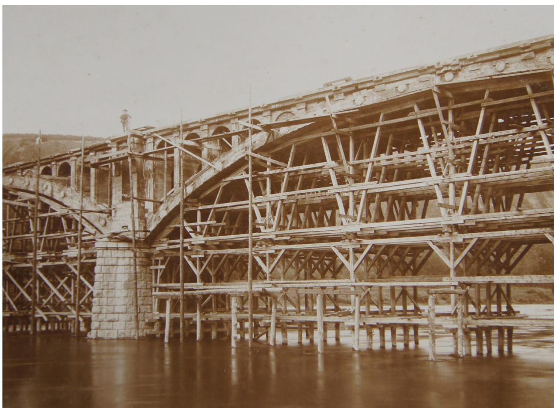
Abbildung 5.2: Gerüst eines Bogens der Moselbrücke Mehring, 1904–1905 [StadtAHOL, Sign. E.4 Nr. 251]
