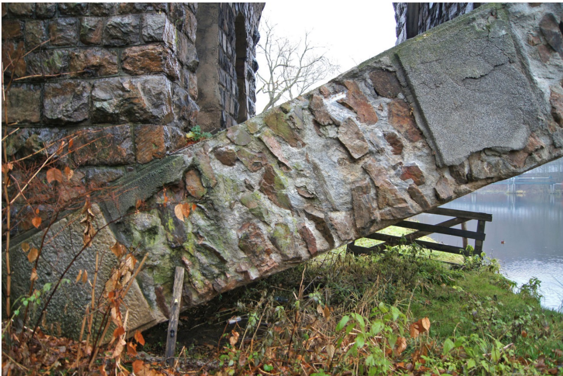
Abbildung 2.1: Bruchstein-Zementmörtel-Bauweise an der Muldebrücke in Göhren, 1902
