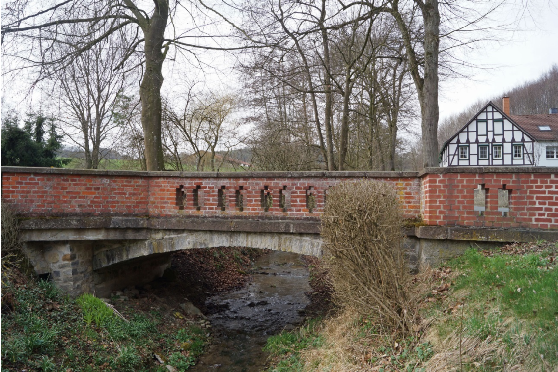
Abbildung 4.54: Die zweite Brücke von Glesse, 1878, Ansicht
