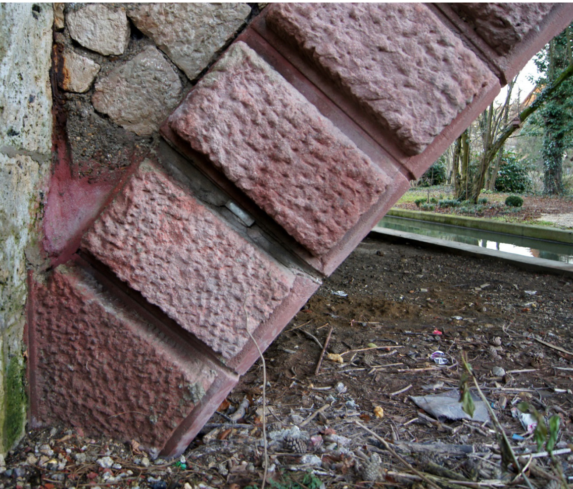
Abbildung 7.33 a-b: Ansicht und Bleigelenk der Schmiechbrücke EHINGEN, 1895
