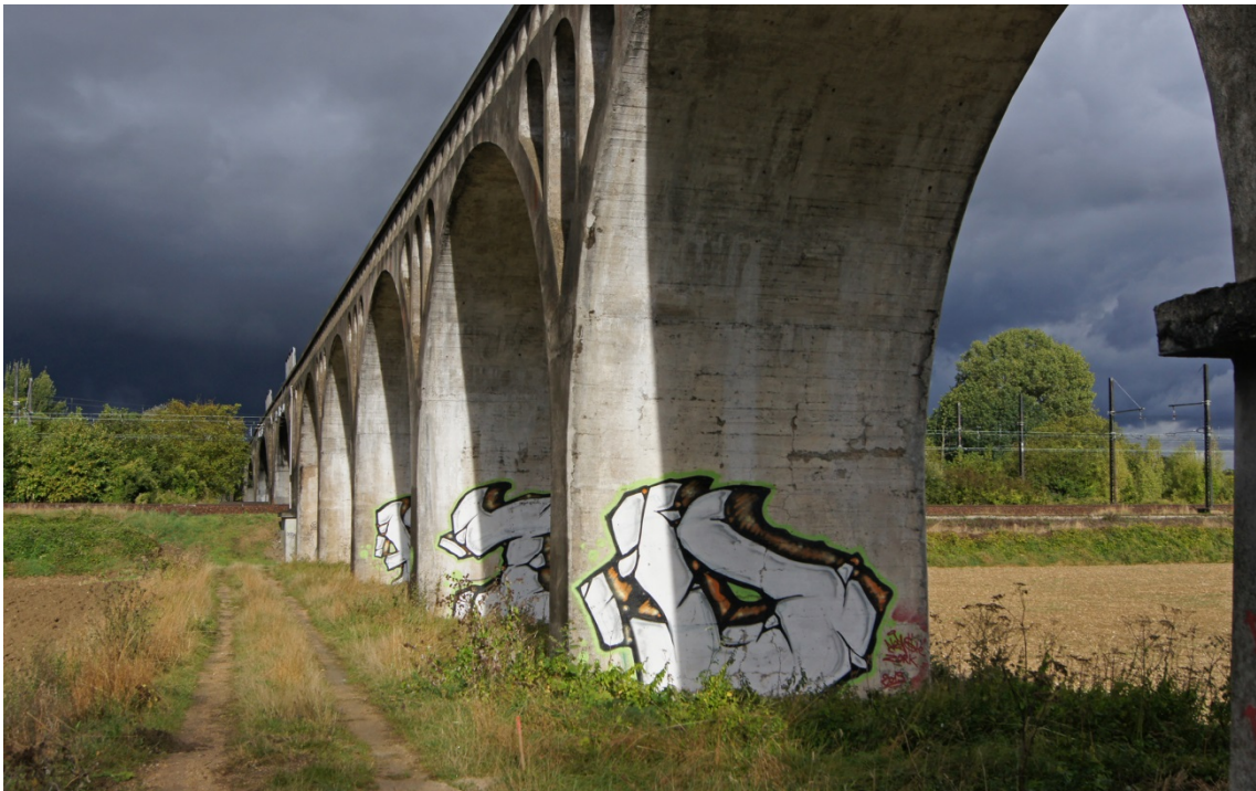
Abbildung 4.20: Aquädukt bei Villeperrot von 1872, Frankreich
