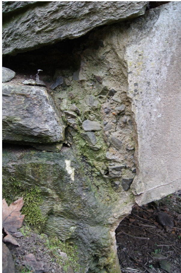
Abbildung 5.50: Detail am Kämpfer des Bogens der Eisenbahnbrücke, Seifersdorf, 1882
