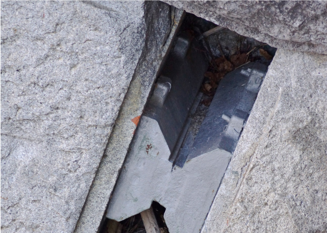
Abbildung 7.65: Wälzgelenk der Corneliusbrücke, München, 1901–1903; vgl. Abb. 7.58
