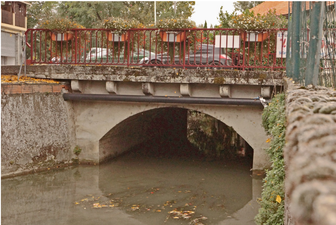
Abbildung 4.12: Ansicht der Betonbrücke von Castelsarrasin, Frankreich, 1836
