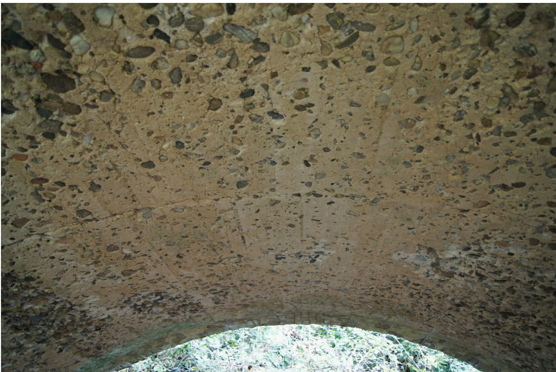
Abbildung 4.11: Bogenuntersicht der Brücke von Villemade, Frankreich, 1835
