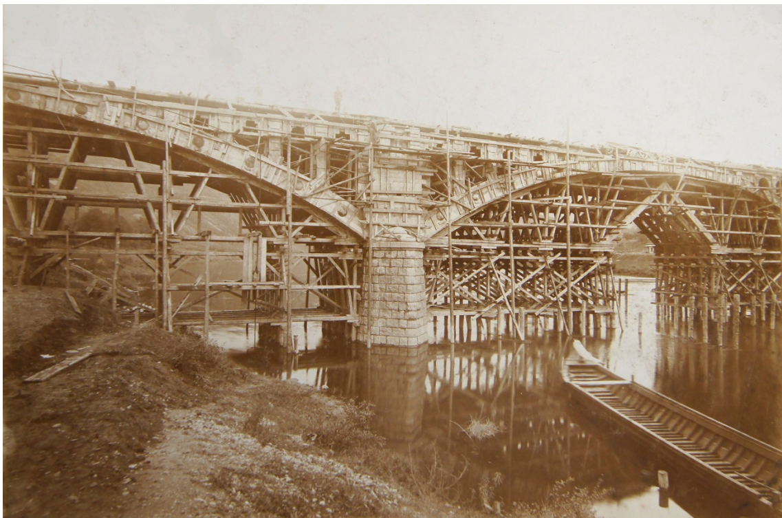
Abbildung 5.96: Ausbildung der Bogenstirn bei der Moselbrücke, Mehring, 1904–1905. Ausbildung der Noppen an der Bogenstirn mittels Modeln [StadtAHOL, Sign. E.4 Nr. 251]
