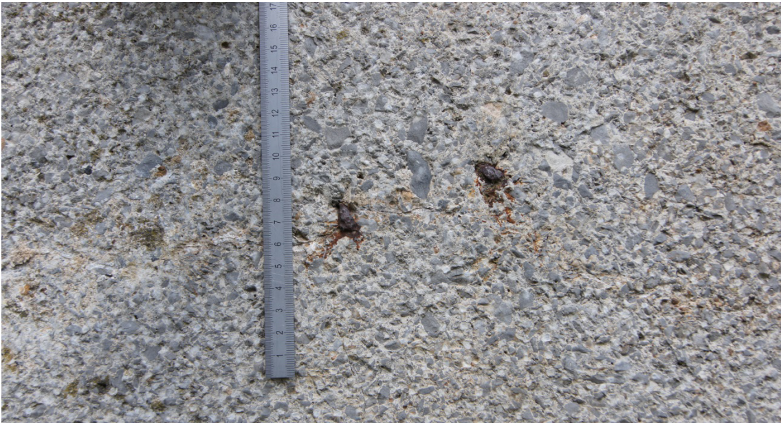
Abbildung 5.55: Spuren der Drahtanker an einer Stütze des Viadukts von Berneau, Belgien, 1916
