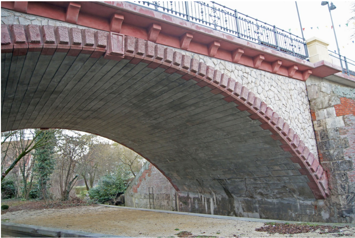
Abbildung 5.85: Fasenleisten und eingefärbte Betonblöcke an der Schmiechbrücke, Ehingen, 1895
