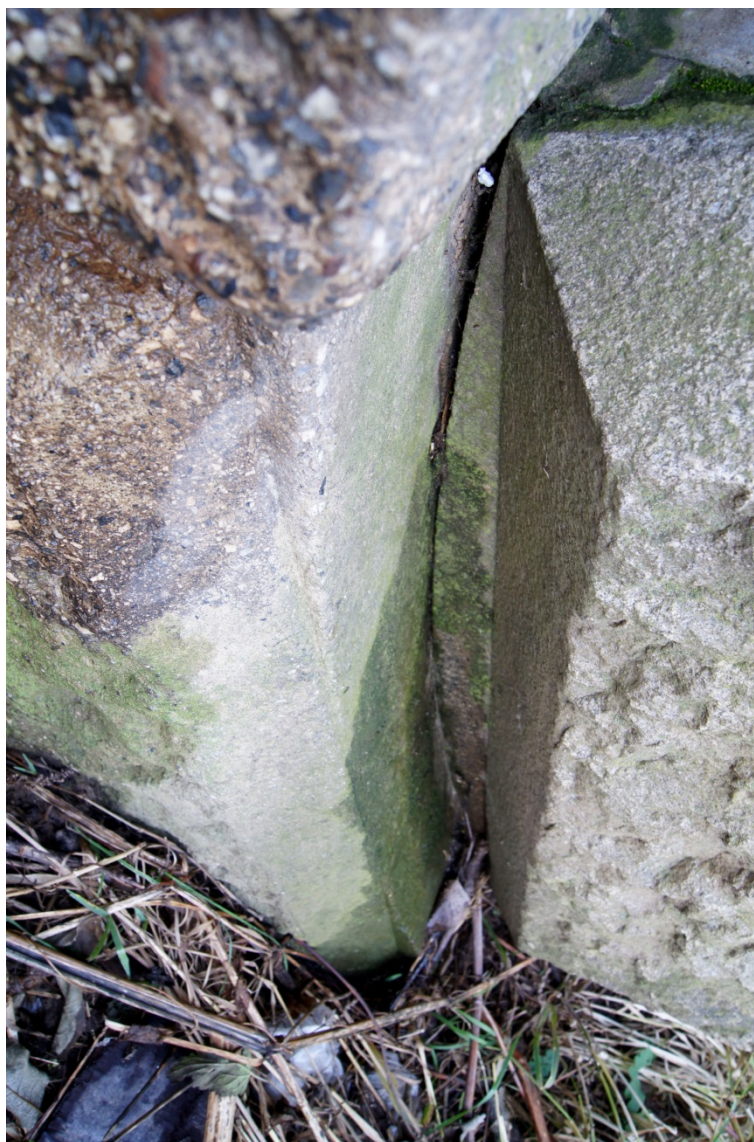
Abbildung 7.45 a-b: Ansicht sowie Detail des Granitgelenkes im Kämpfer der Leinebrücke in Grasdorf, 1899–1900
