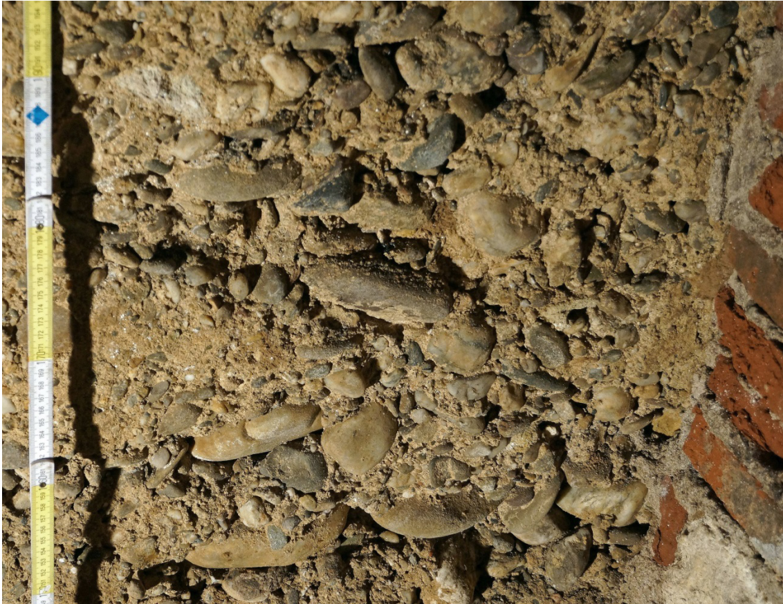
Abbildung 4.4: Detailaufnahme des verwendeten Betons im Keller von Gaillac, 1832
