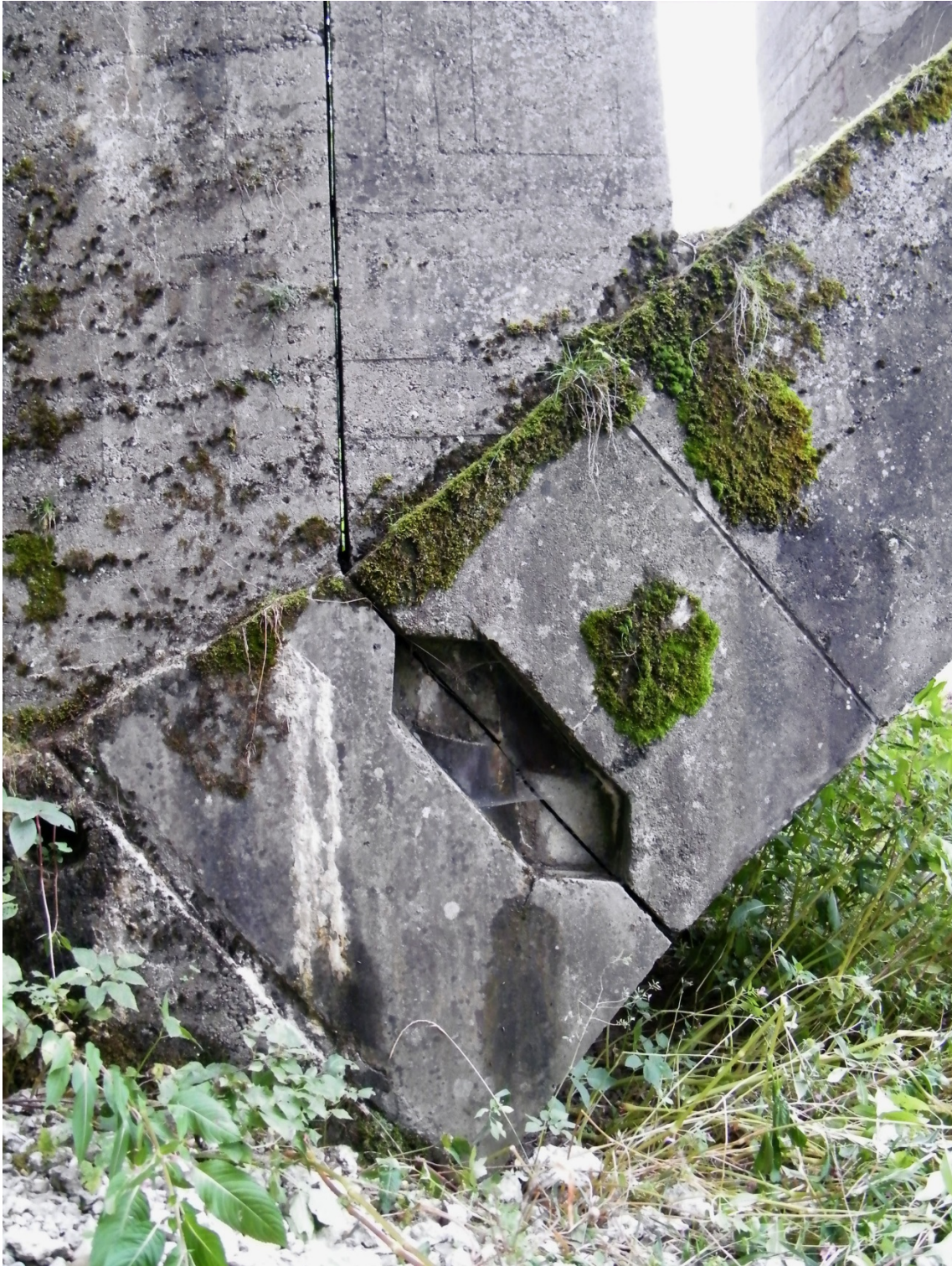
Abbildung 8.51: Ansicht des Kämpfergelenkes mit der anschließenden Dilatationsfuge, Illerbrücke in Lautrach, 1903–1904
