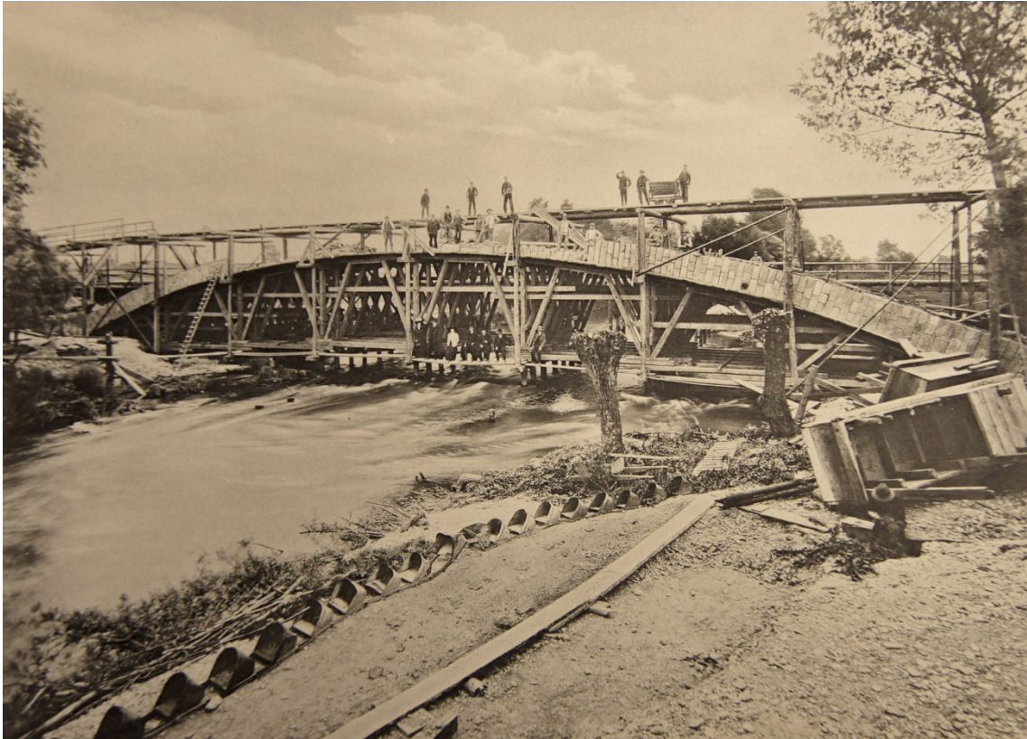
Abbildung 5.5: Lehrgerüst der Almebrücke in Elsen, 1910 [StadtAHOL, Sign. E.4 Nr. 53, o. S.]
