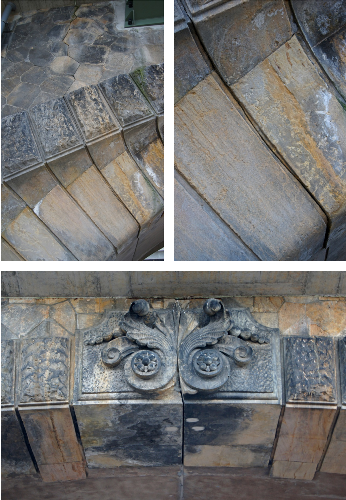
Abbildung 7.52 a-c: Betongelenk der Marienbrücke in Dresden, 1896 a) Ansicht des Gelenks mit darüber liegender Dilatationsfuge b) Krümmung des Gelenksblocks in der Fuge sichtbar c) Scheitelgelenk mit Schmuckstein
