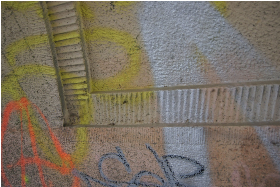
Abbildung 5.90: Weiteres Beispiel der Kassettierung an der Göltschbrücke, Rodewisch, 1924, mit steinmetzmäßiger Bearbeitung
