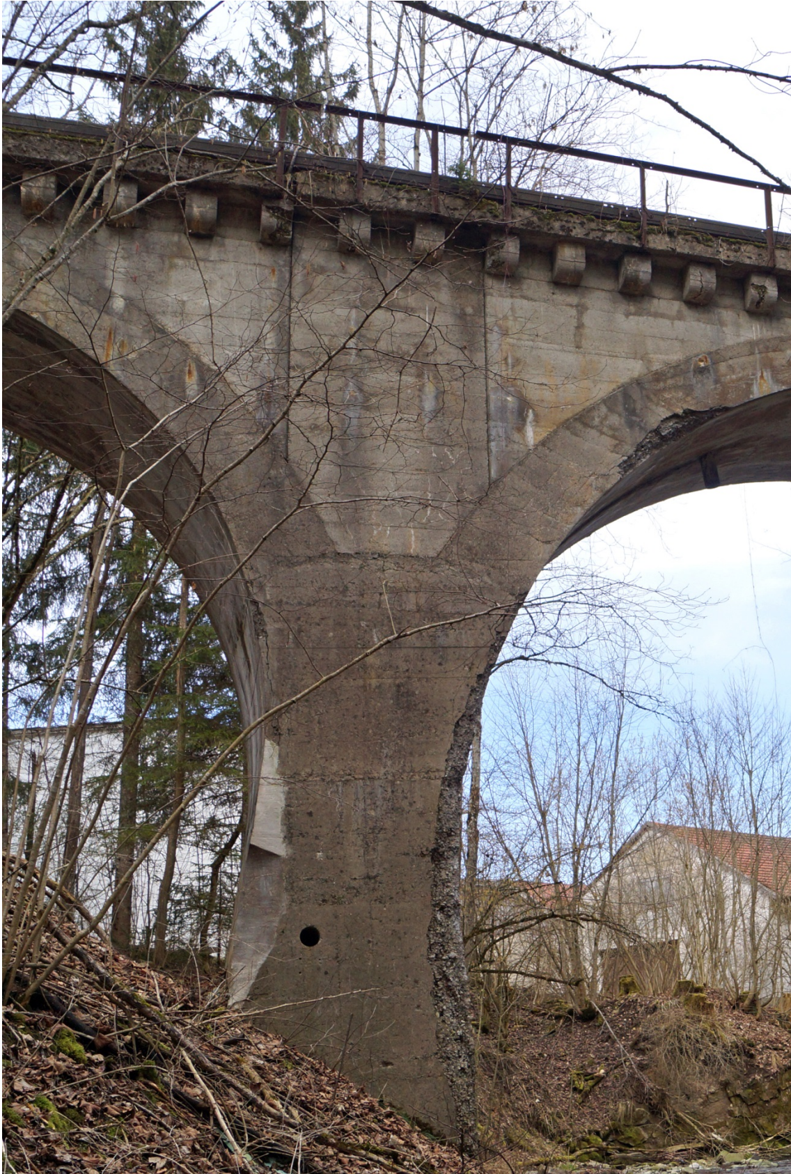
Abbildung 7.25: Pfeiler mit darüberliegenden Fugen an der Rottachbrücke in Kempten-Rothkreuz, 1908
