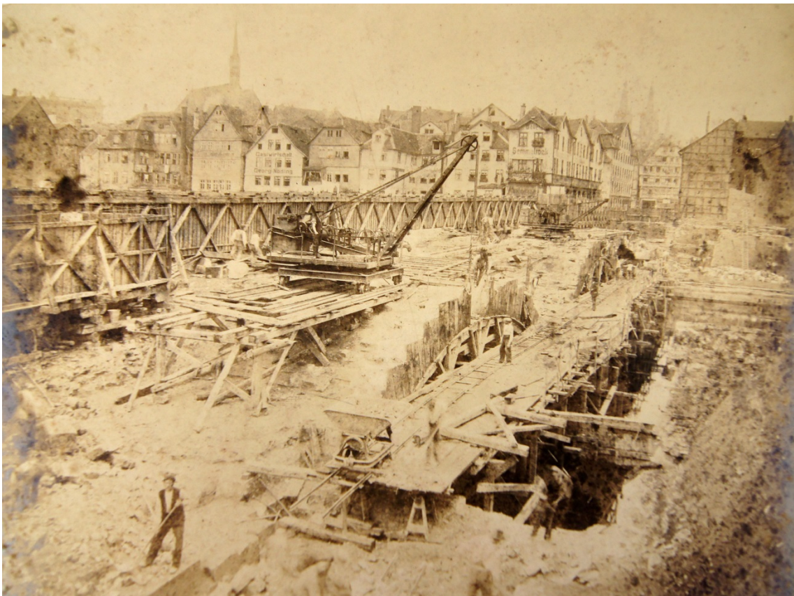
Abbildung 5.76: Mittig und seitlich liegende Versorgungsbahnen, Fuldabrücke, Kassel, 1909–1910 [StadtAHOL, Sign. E.4 Nr. 13]
