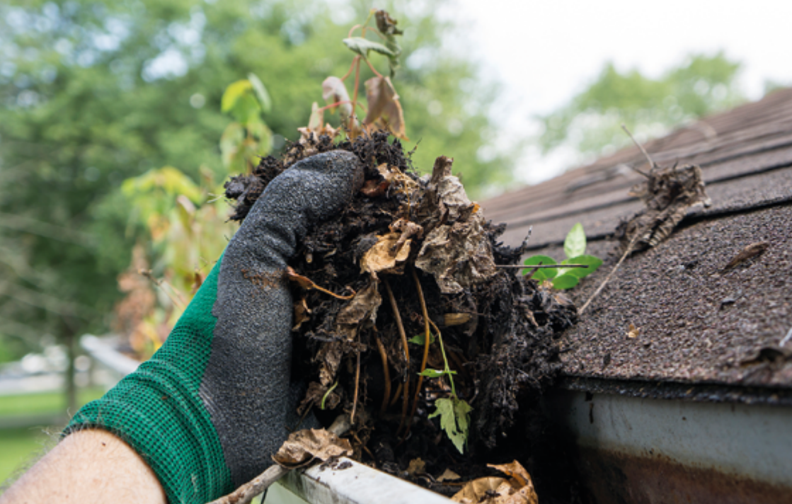
Abb. 22: Dachrinnen sollten immer frei durchlässig sein.
