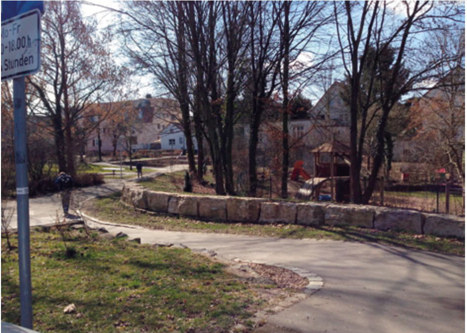
Abb. 120: Auch bei diesem Kindergarten in Ditzingen sind die Kosten des Hochwasserschutzes langfristig niedriger als die Kosten der Überflutungsschäden.
