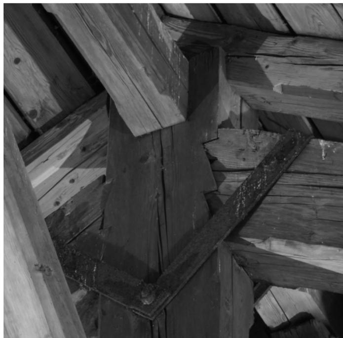
Abb.165: Reithalle Aarau, Eisenbügel zur Sicherung der Verbindung Hängesäule/Hauptstreben
