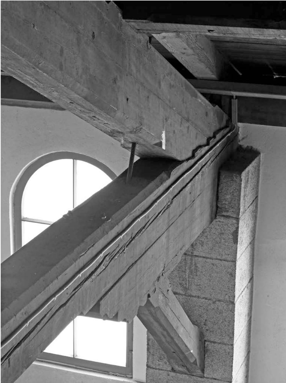
Abb.182: Einsteighalle in Hof, Verbindungsdetail der beiden Streben und des Zerrbalkens mit jeweils doppeltem Versatz
