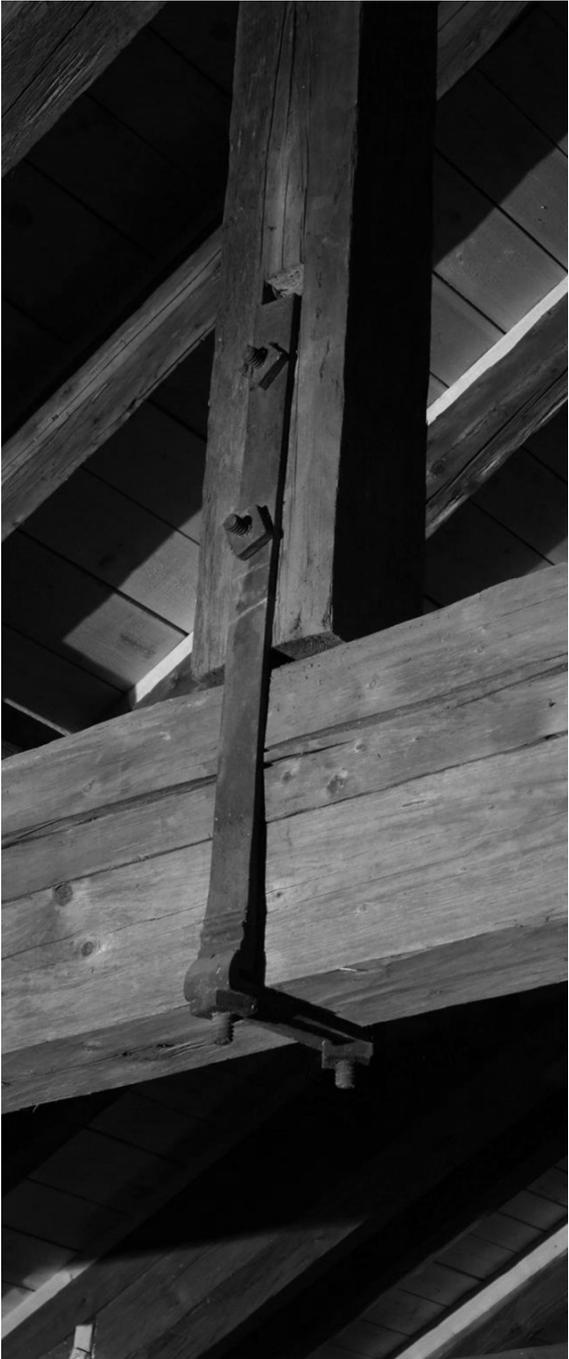
Abb.211: Umgreifendes Hängeseisen um Spann- und Kehlbalcken
