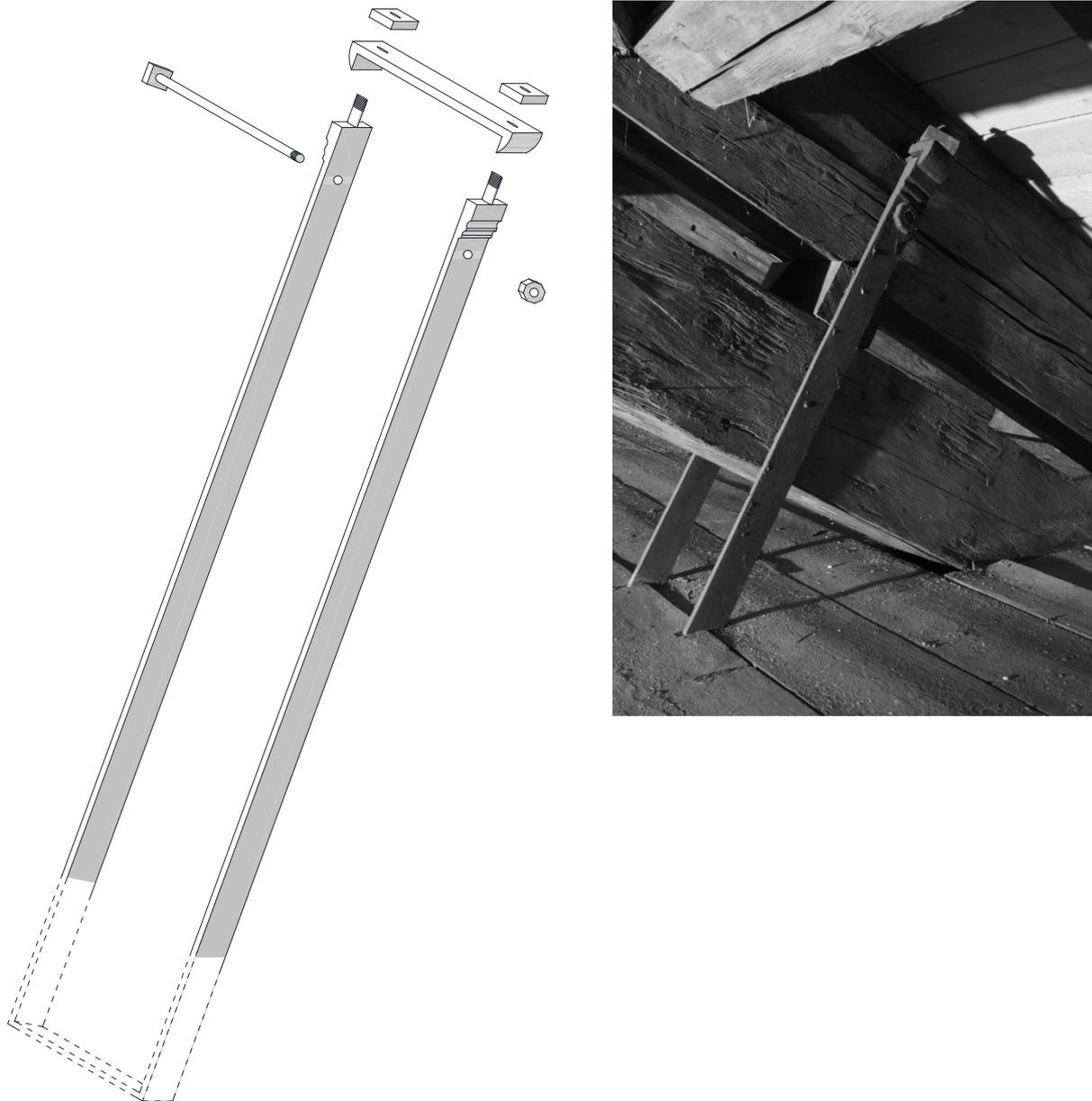
Abb.212: Eisenbügel am Fußpunkt (unterer Bereich aufgrund fehlender Zugänglichkeit nur vermutet)
