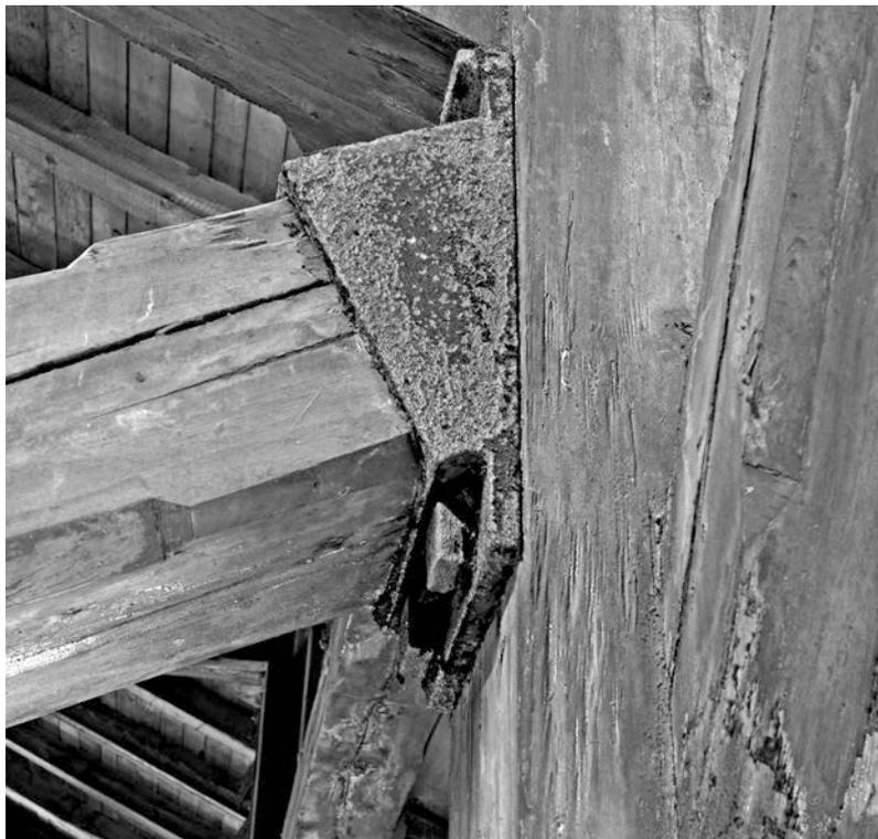
Abb.180: Einsteighalle in Hof, Eisenschuh als Verbindungsdetail von Hängesäule und Strebe
