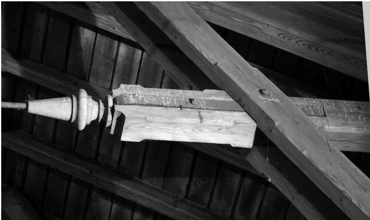
Abb.171: Verbindungsdetail waagrechtes Zugeisen/ Stichbalken
