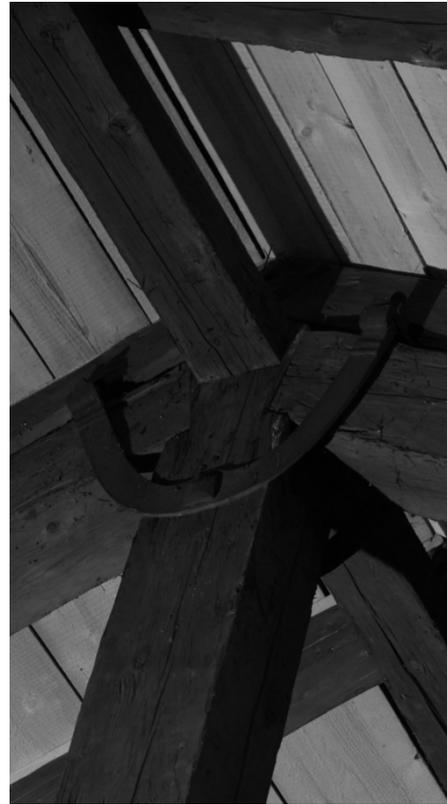
Abb.210: Eisenklammer am Firstpunkt
