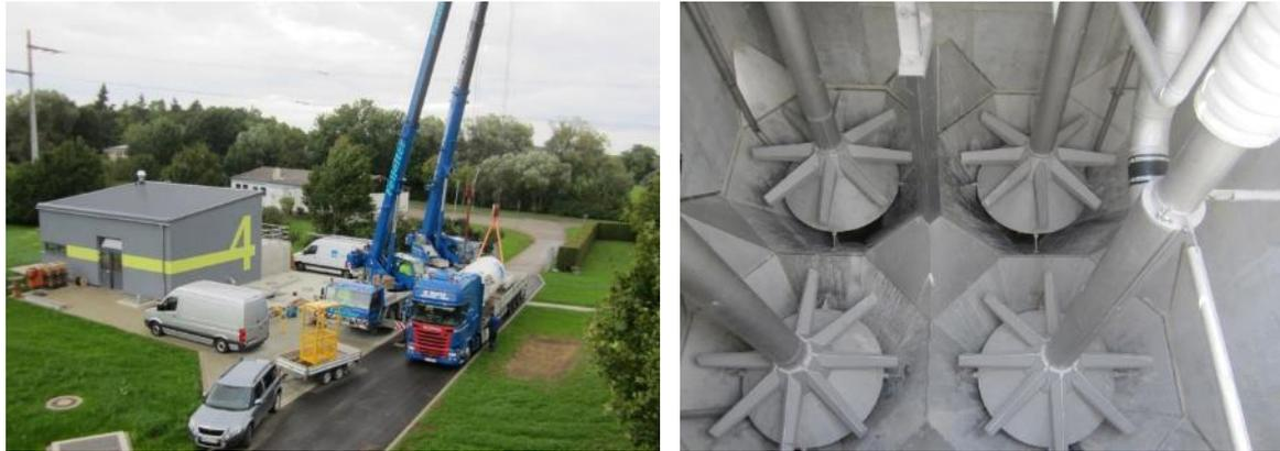
**Abbildung 9: Aufbau Sauerstofftank (links) und leere Filterzellen (rechts), Bilder: Ingenieurbüro Dr. Resch + Partner PartG**
