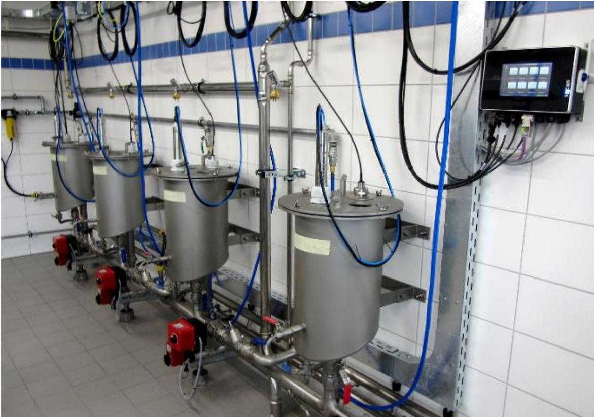
Abbildung 65: Messtöpfe mit Sonden (Zulauf & Ablauf Ozonung, Ablauf Sandfilter/Aktivkohlefilter)
