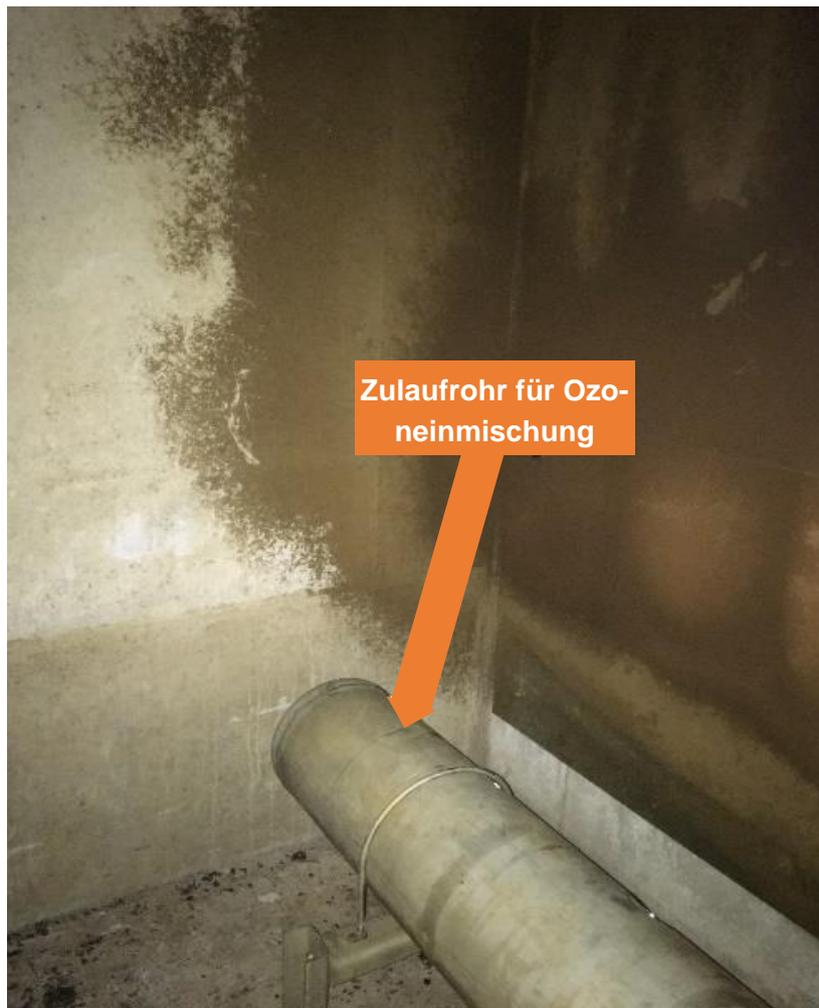
**Abbildung 119: Ausfällungen im vorderen Teil des Ozonreaktors, Bild: Ingenieurbüro Dr. Resch + Partner PartG**
