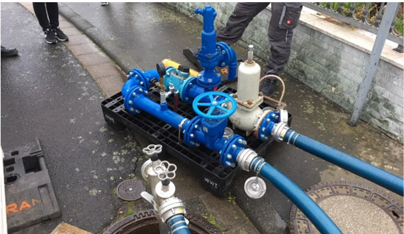
Abbildung 16: Einspeisung über mobile Leitungen in das Leitungsnetz (Bildquelle: Merbs, 2018)
