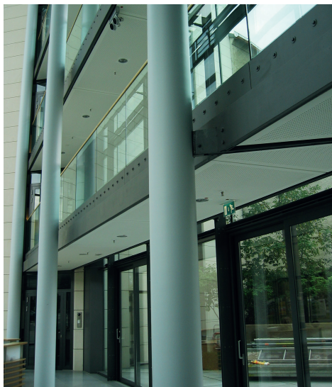
Bild 6 Links: Beispiel für Kat.-B-Brüstung mit Klemmblech; Rechts: mögliche Konstruktionsdetails
