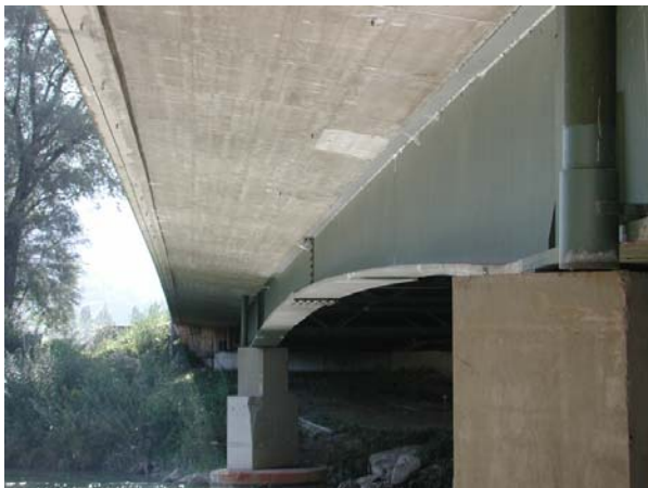
Abb. 6.1: Brückenansicht von unten
