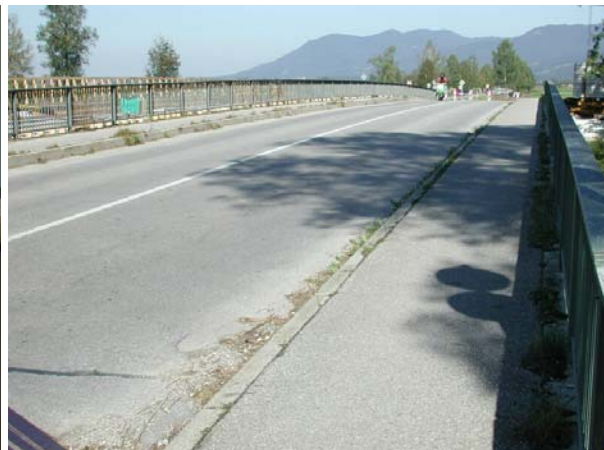
Abb. 6.2: Brückenansicht von oben
