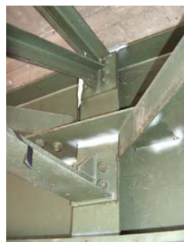
Abb. 6.18: Ansicht der Querverbände Abb. 6.19: Knotenpunkt Abb. 6.20: Lösen der Verbindung
