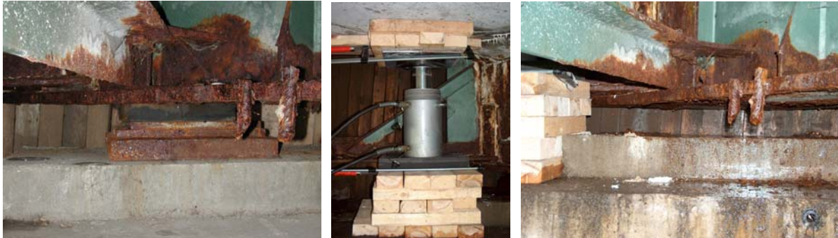
Abb. 6.12: Lager im Ausgangszustand Abb. 6.13: Hydr. Presse Abb. 6.14: Lager vor dem Absenken
