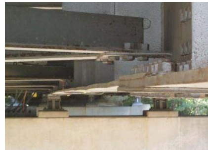
Szenario 3: deformierter Träger
