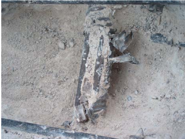
Abb. 6.16: Freigelegtes Spannglied
