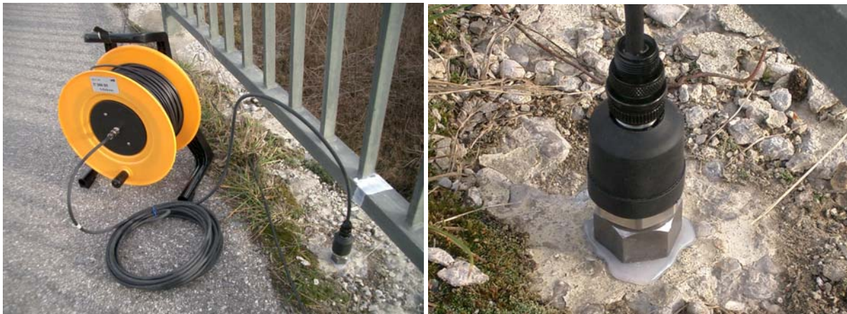
Abb. 6.51: Installation der Schwingungssensoren Abb. 6.52: Befestigung der Sensoren mit Klebstoff
