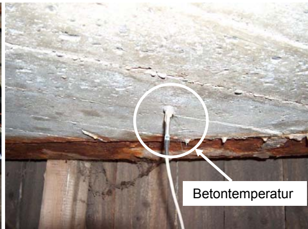
Abb. 6.56: Messung der Betontemperatur
