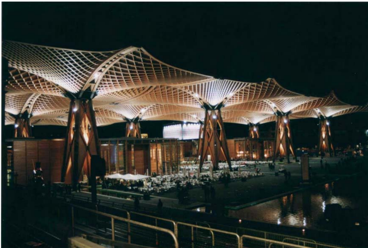
Abb. 1-1: „Expo-Dach“ Hannover, vier Brettrippenschalen in freier Form bilden einen Schirm (Planung/Foto IEZ Natterer)
