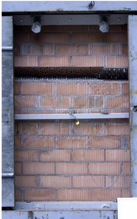
Abbildung 4.3: Unverstärkter Prüfkörper MD-W3 mit typischem Biegezugversagen zwischen Mauerstein und Mörtel in einer Lagerfuge nach einer Druckstoßbeanspruchung im Stoßrohr.
