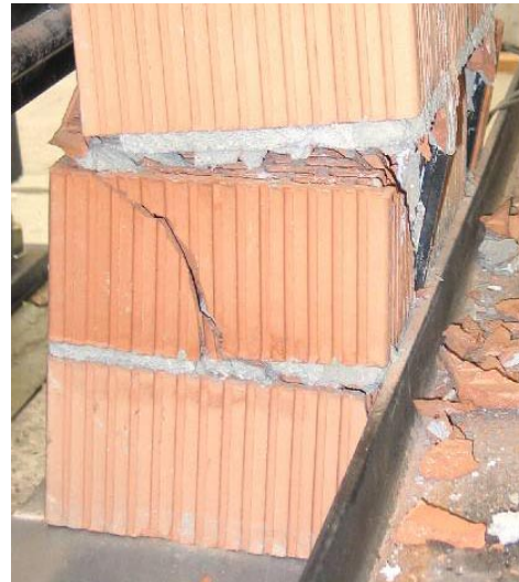
MS2T-2 (Verstärkung zwei CFK-Lamellen)
