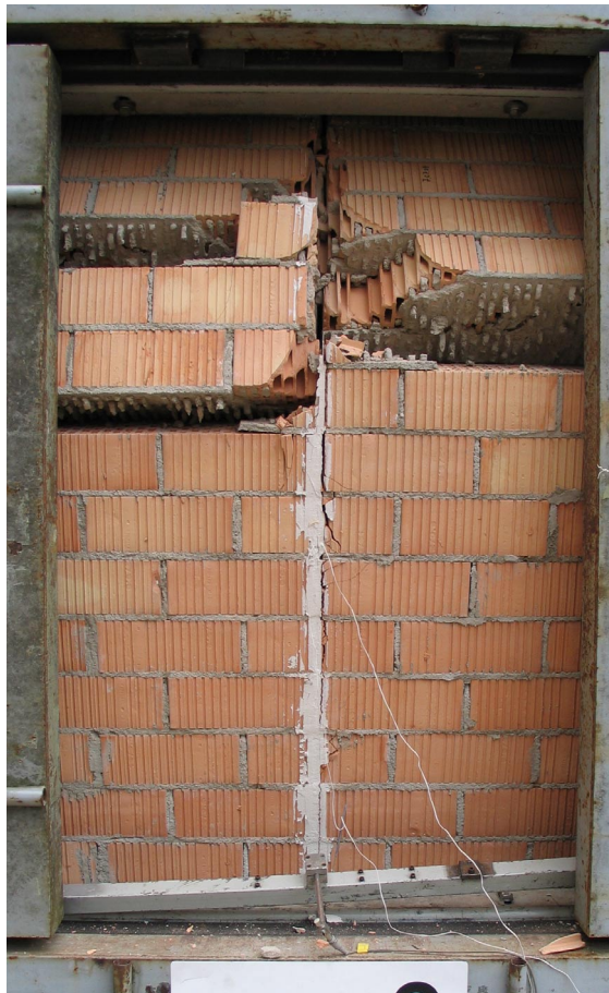
Abbildung 4.7: Endverankerungsversagen am oberen Auflager des Prüfkörpers MD1-W2 nach einer Druckstoßbelastung im Stoßrohr.
