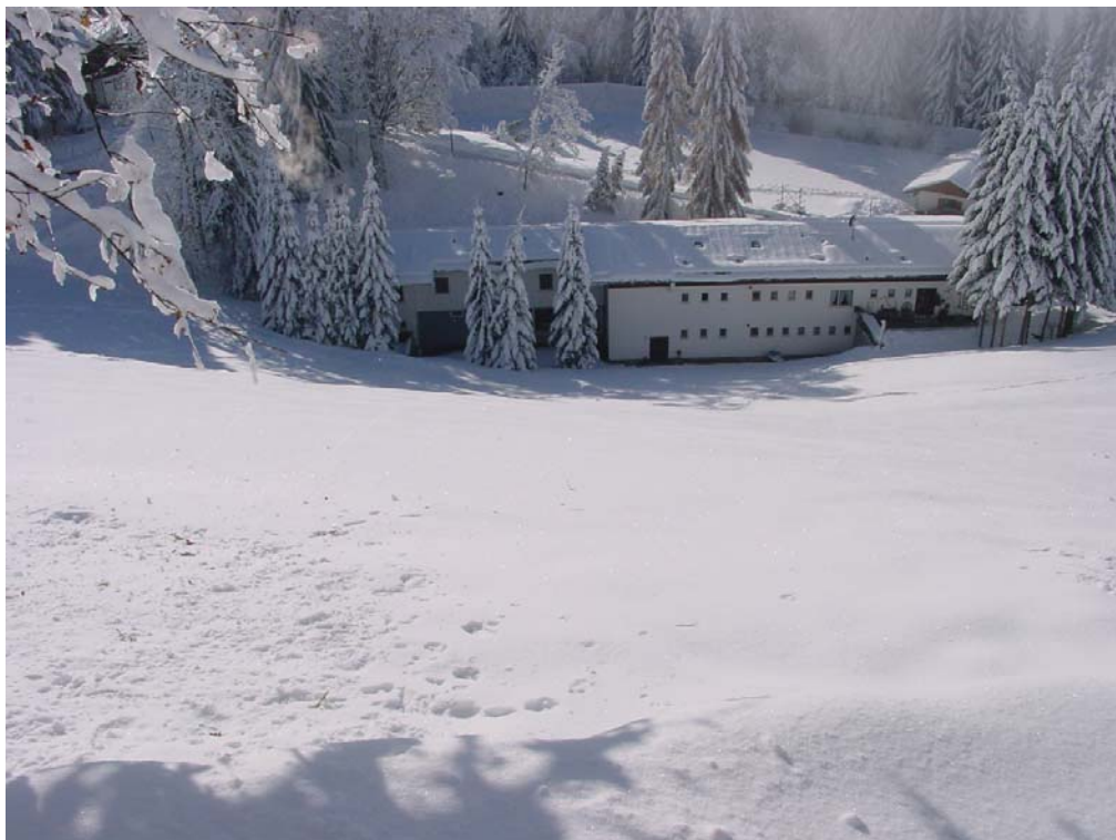
Abb. G.7: Internatsgebäude Haus Schneibstein.
