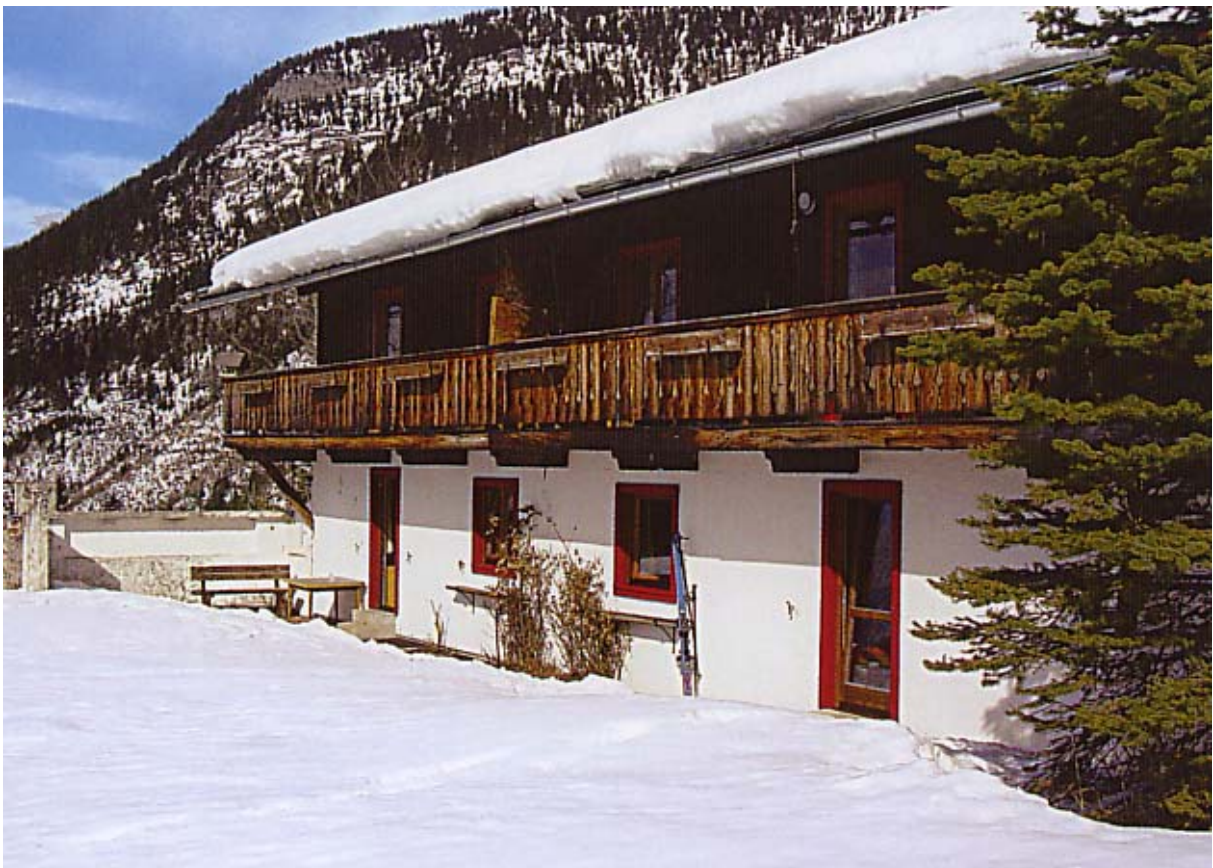
Abb. G.5: Internatsgebäude Haus Königssee.
