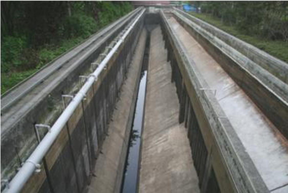
**Abbildung 40: Belüfteter Sandfang der Kläranlage Dachau.**
