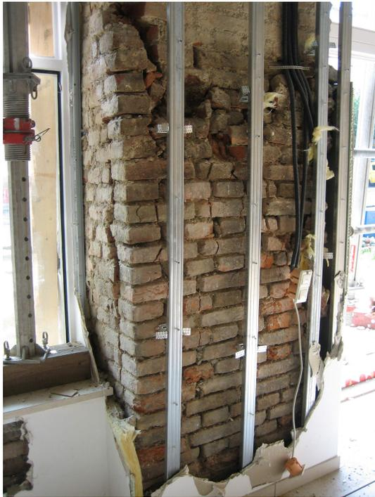
(a) Querzugversagen eines Mauerwerkpfilers
